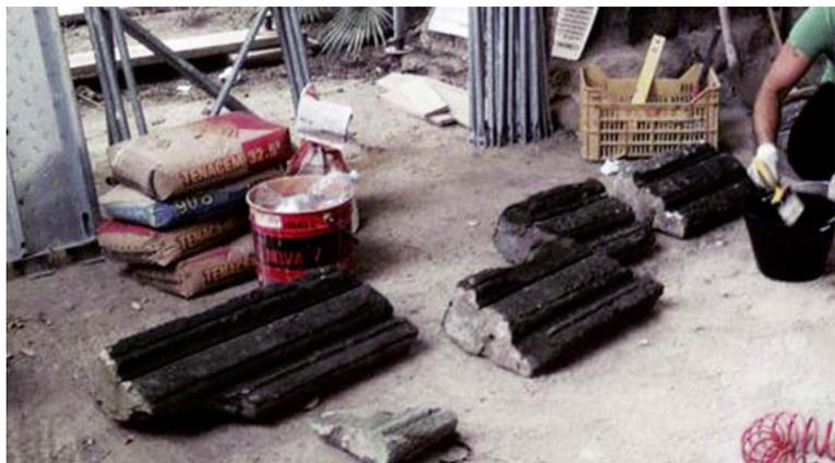
Fig. 5 – Fasi di pulitura dei ritrovati elementi architettonici della parasta di destra del portale del Sedile Nobile di San Luigi in Aversa.
