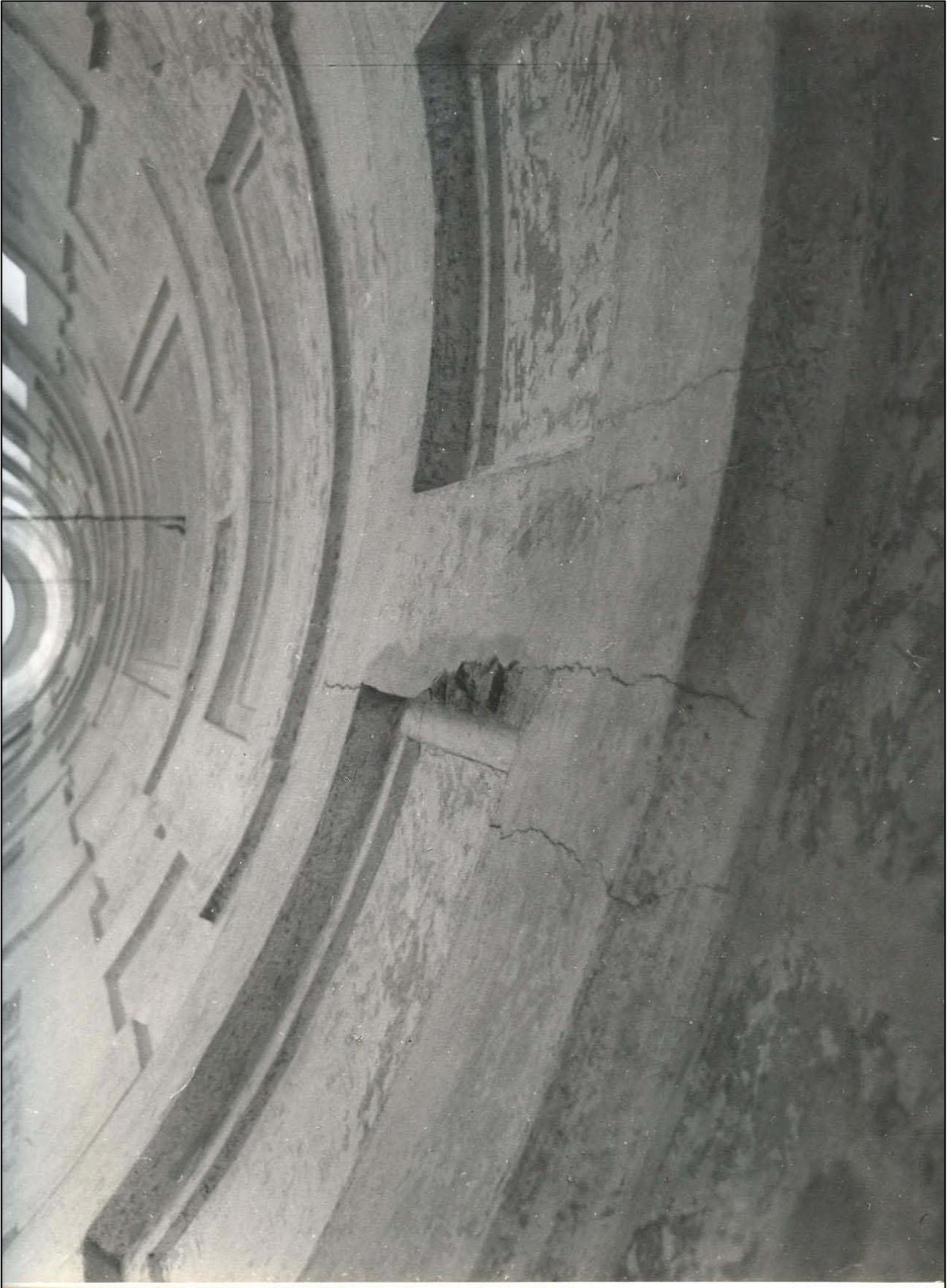
Figura 13 - Uffizi, lesioni alla volta del portico.
