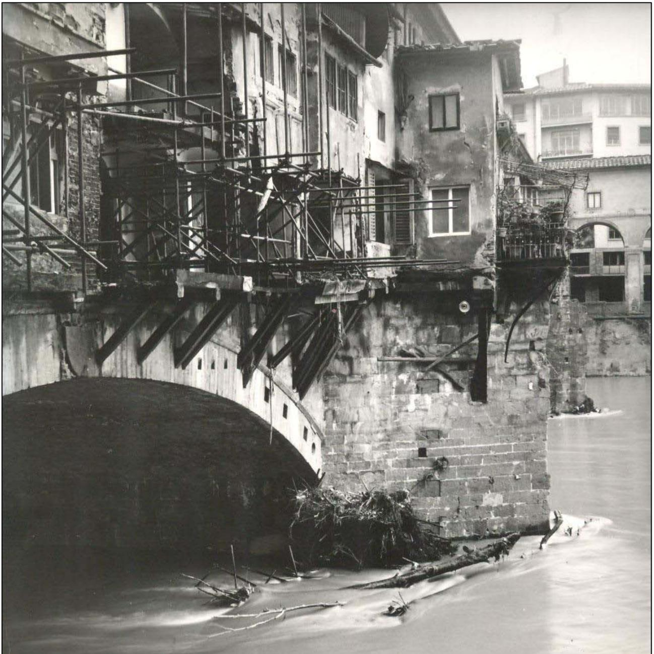
Figura 2 e 3 - Botteghe su Ponte Vecchio distrutte dalle acque.
