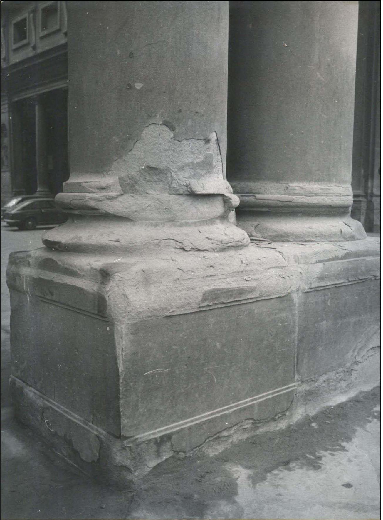
Figura 11 - Uffizi, basi delle colonne del loggiato erose dalle acque.
