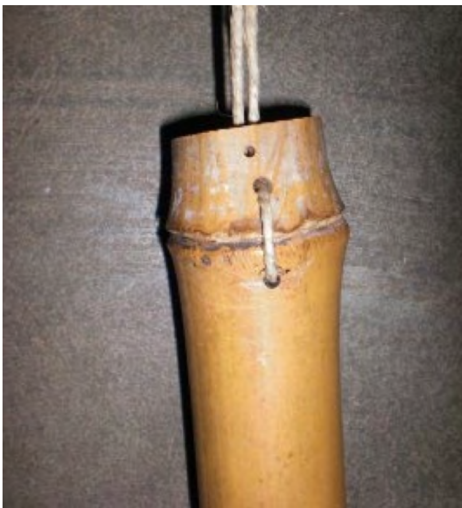
Dettaglio dell'applicazione dello spago al bambù.
