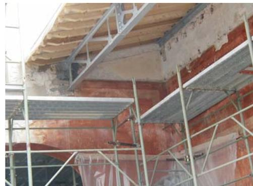
**62. Nuovo tetto della serra destra in costruzione. Al di sotto, le tracce del tetto originario**
