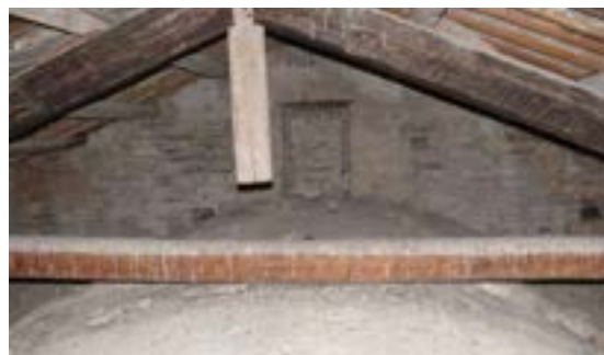
Figura 16 Capriata esistente, poggiante sulla volta
