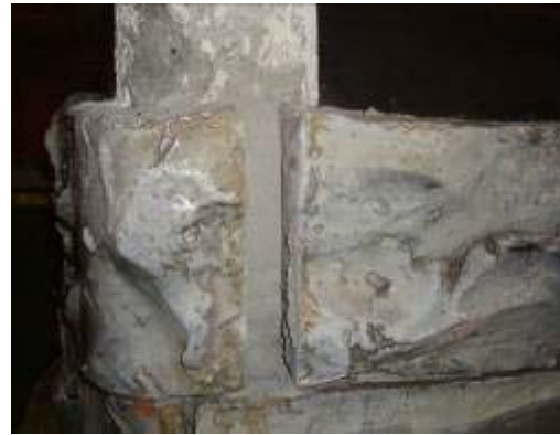
Figure 11. Prospetto sotto il segno della luna: la rimozione dell'integrazione in malta cementizia.
