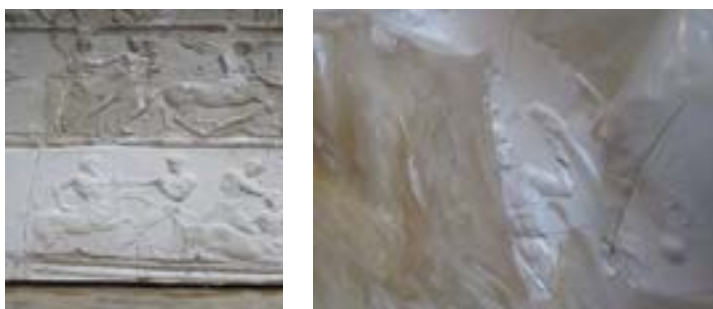
Immagini 9 e 10. Due fasi di pulitura con Agar-Agar portato a secchezza; su numerose zone l'operazione è stata ripetuta a causa dell'ostinazione delle macchie superficiali.
