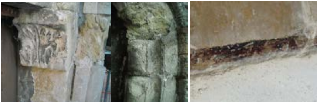
Figura 24 Capitello del portale durante la pulitura e blocco di pietra polverizzata in secondo piano; Figura 25 Blocchi di pietra del portale a conservazione differenziata; Figura 26 Fascia di pietra dipinta di rosso
