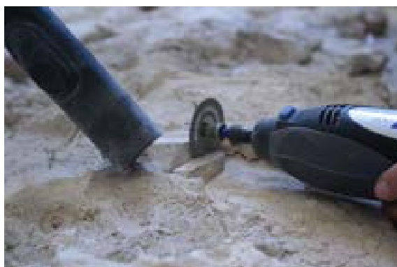
Figura 9, molatura e assottigliamento dello spessore dell'intonaco
