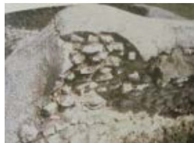
Figura 2. Solunto (Pa). La mancata predisposizione di giunti di dilatazione nelle copertine ha causato la formazione di linee di frattura che hanno interessato anche la sottostante struttura antica. [1]
