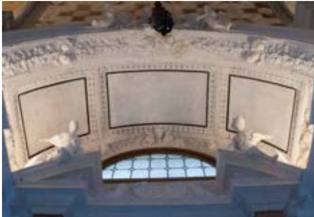
Fig. 19. Una visione d’insieme della Cappella di S. Gualberto ultimato l’intervento.
