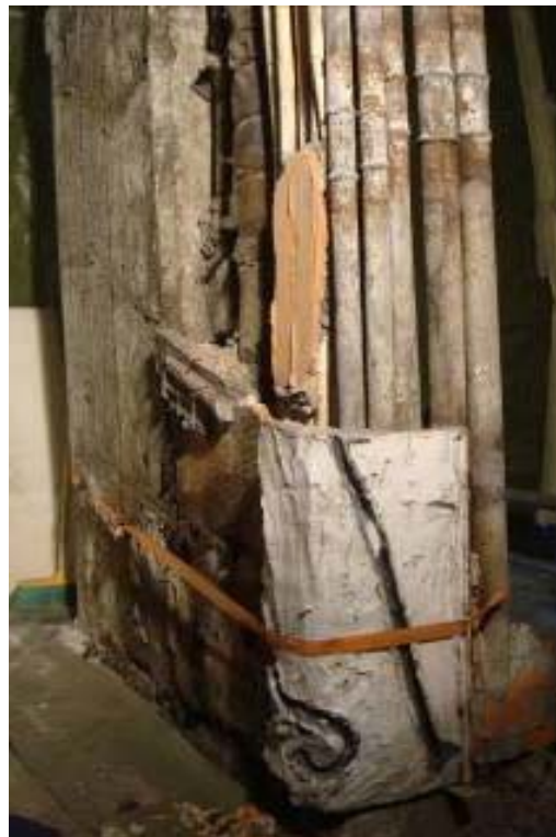
Figure 13. Durante le operazioni di smontaggio delle formelle.
