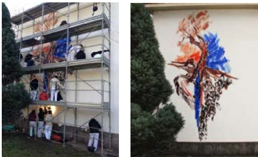
Fig. 1. Cantiere di restauro dell'opera di Bernard Zimmer, Sopra/Sotto , acrilico su muro, 1995, padiglione 7 MAPP, Milano
