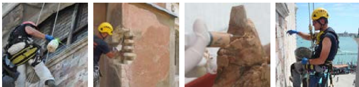
Figura 19-20-21-22 - Fasi relative all'attività di conservazione preventiva e messa in sicurezza delle facciate di Palazzo Ducale
