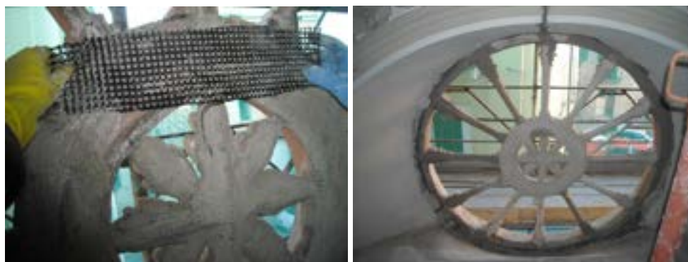
Figura 29 Applicazione di una fascia di fibra di carbonio sul retro del rosone; Figura 30 Retro del rosone dopo restauro
