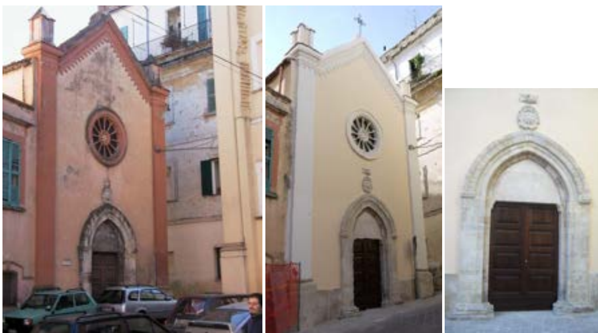
Figura 33 Facciata di Sant’Agata prima del restauro; Figura 34 Facciata di Sant’Agata dopo il restauro; Figura 35 Portale
