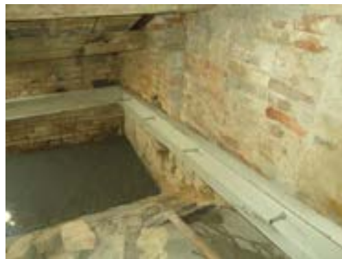
Figura 14 Cerchiatura metallica
