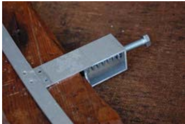
Figura 6. Particolare del montaggio del profilato ad U con la piattina in alluminio
