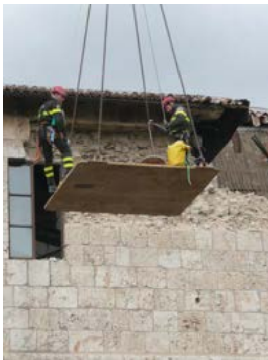
Figura 4 L'Aquila, emergenza sisma 2009, i gruppi SAF dei Vigili del Fuoco all'opera su piattaforme aeree per recuperare le opere danneggiate all'interno del Forte Spagnolo
