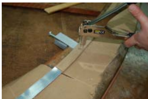
Figura 8. Particolare del montaggio del profilato ad U con la piattina in alluminio e le fasce perimetrali
