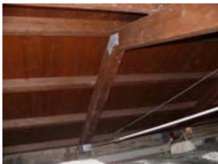
Figura 17 Particolare capriata con tirante d'acciaio (L.L.)
