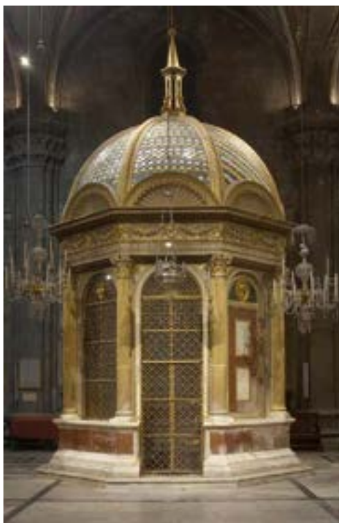
Figura 1. Il Tempio del Volto Santo prima del restauro
