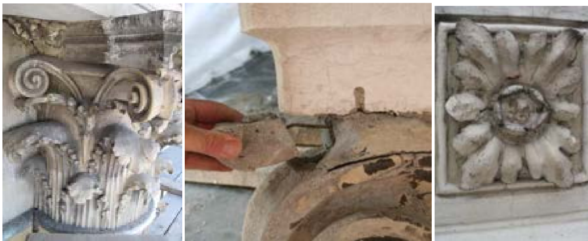
Figure 4-5-6. Le foglie dei capitelli sono realizzate a stampo, con un'anima in ferro e una miscela di malta idraulica e pozzolana. Sono realizzati con la medesima tecnica le mensole e i fiori della cornice della trabeazione.
