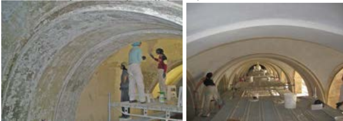
Figura 6 e 7 Durante il descialbo degli intonaci antichi a calce delle volte al piano terra e durante le velature a calce
