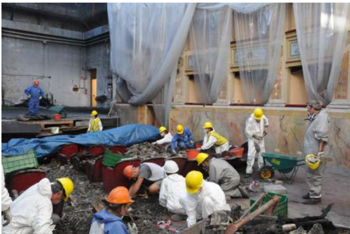
Figura 3. Tolentino (MC), incendio del tetto e della volta del Teatro Nicola Vaccaj 2008, volontari impiegati nella cernita delle macerie per il recupero dei frammenti di intonaco dipinto della volta.
