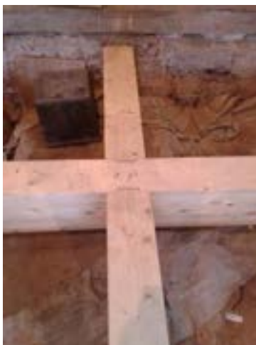
Figura 4. Dettaglio della struttura di supporto della nuova pavimentazione in travi in legno lamellare e disegno dell’andamento delle travi.
