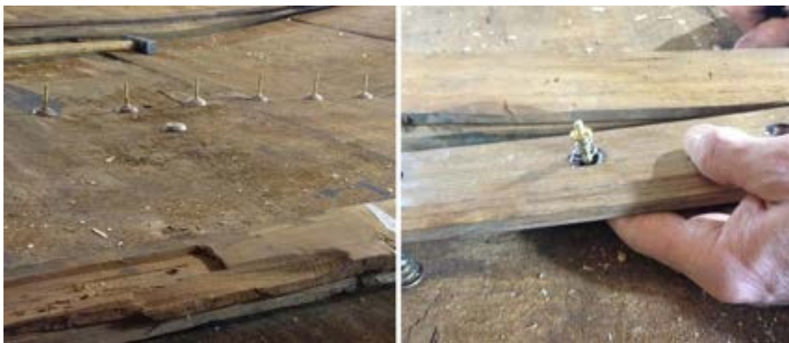
Figura 8 e 9. La posa dei supporti con le viti oscillanti e il dettaglio di un assieme vite-molla-dado assemblato sulla nuova traversa centrale.
