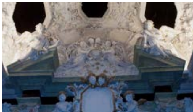
Fig. 20,21 e 22. Alcuni particolari della cappella del Rosario dopo il restauro.
