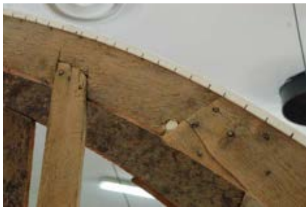
Figura 10. Particolare del listello distanziatore applicato al vecchio telaio
