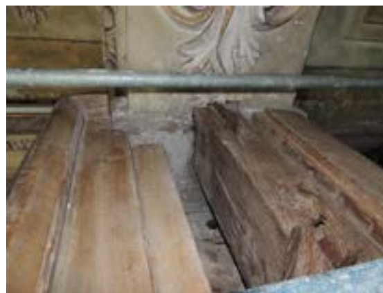
fig. 4 La trave con l'innesto nella muratura e il gancio in ferro
