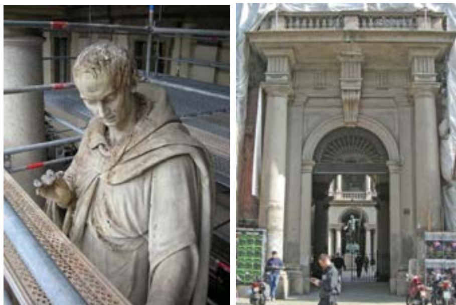
Figura 11 e 12 Statua in marmo a piano terra della loggia e portale della facciata in granito di baveno, prima dell’intervento
