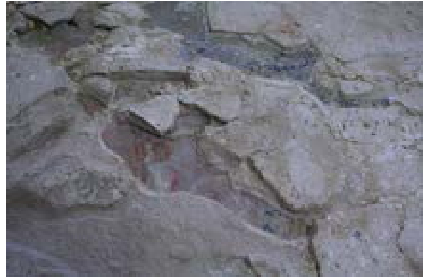
Figura 7 , distacchi interstrato; Figura 8 , strappi occasionali
