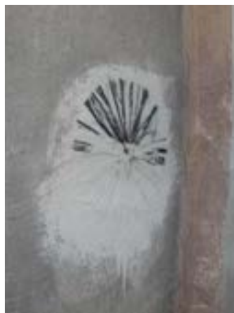
Figura 9 Connettori in fibra di carbonio
