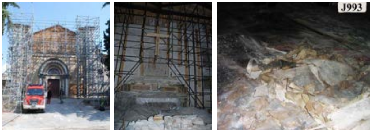
Figure 1-3. La chiesa di San Francesco da Paola a L’Aquila dopo il terremoto dell’aprile 2009, l’altare distrutto e i danni causati al dipinto di Bedeschini (ampie lacerazioni, perdita di settori di tela, distacchi di preparazione e colore, schizzi di sostanze estranee, detriti)
