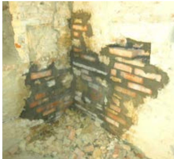
Figura 8 Intervento di cucì scuci
