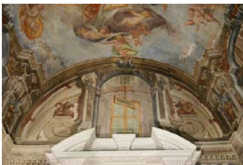
Figure 14 particolare della zona alta parete di fondo cappella di San Carlo dopo il restauro
