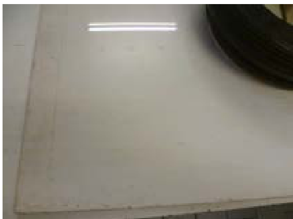
Figura 4. Particolare dello sporco e delle cadute di materia
