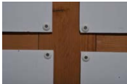
Figura 14. Particolare delle viti di vincolo dei pannelli di poliplat al telaio
