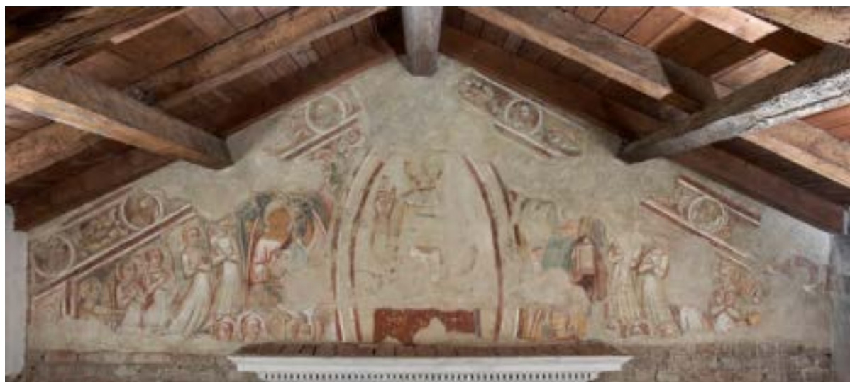
Figura 10. Affreschi parete absidale dopo il restauro
