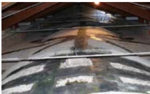
Figura 15 Volta consolidata con fibre di carbonio
