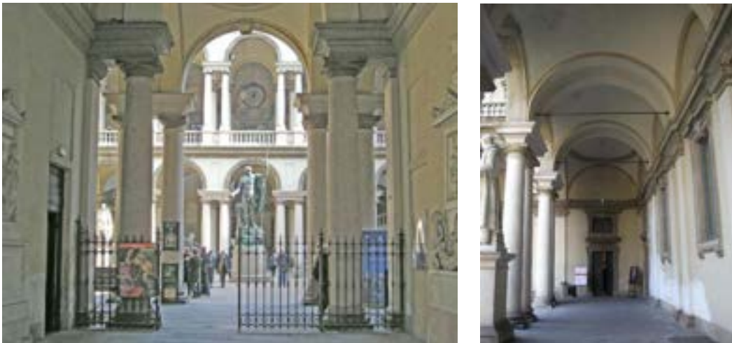
Figura 4 e 5 Atrio di ingresso e loggia piano terra prima dell’intervento di restauro
