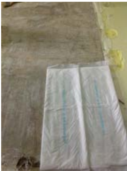
Figura 6. Compresse di Acetone funzionali alla rimozione dell'intelleggio
