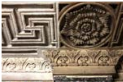
Figura 11. Cornice marcapiano, a sinistra dopo la rimozione del gel di agar.
