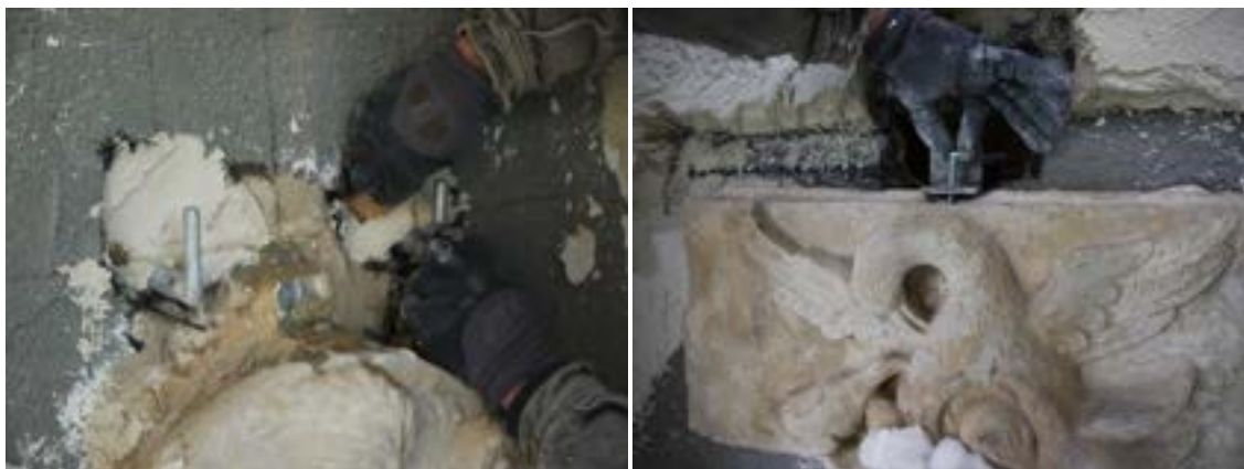
Figura 31 Posizionamento delle staffe nel muro su cui viene appoggiata la lastra in pietra; Figura 32 Staffa bloccata nel muro al di sopra della lastra, vincolata a questa grazie ad un perno metallico poi stuccato.
