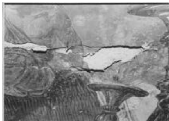
Figura 16. Sala napoleonica: lacune della malta di finitura
