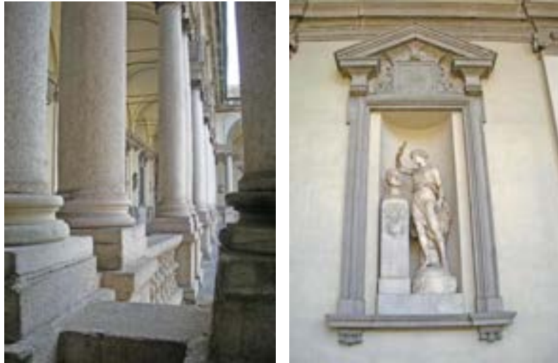
Figura 8 e 9 Colonnato in granito e statua in marmo della loggia del primo piano all’interno di cornice in ceppo lombardo, prima del restauro
