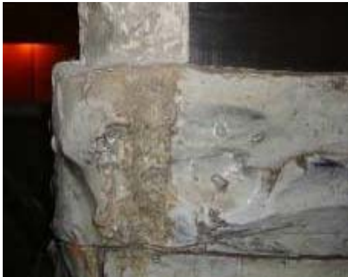
Figure 10. Prospetto sotto il segno della luna: l'integrazione in malta cementizia prima della rimozione.
