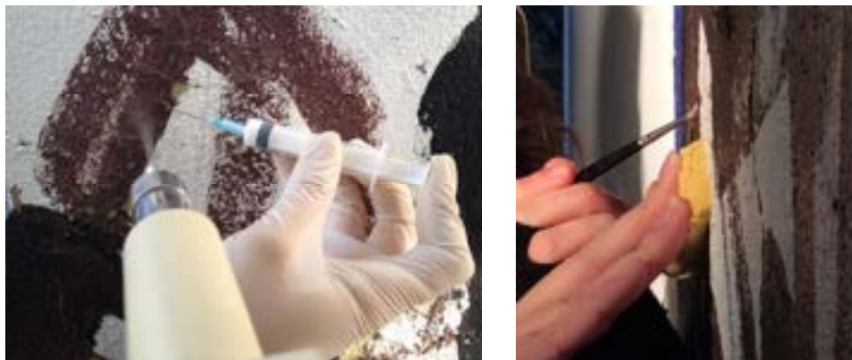
Fig. 10 e 11 Foto applicazione adesivo a iniezione ed a pennello con l'ausilio del getto di vapore.
