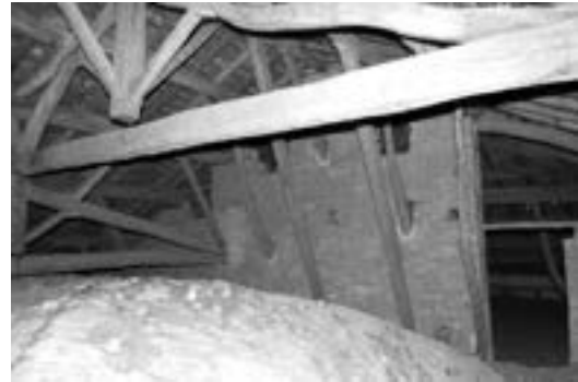
Figura 2. Sottotetto, parte centrale sopra la volta
