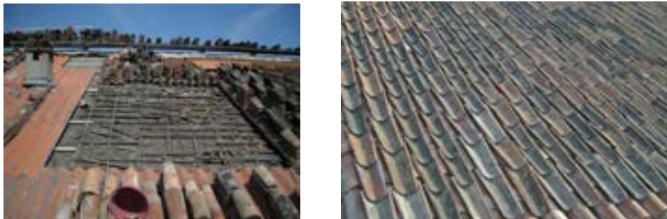
Figura 20 e 21 Durante e dopo la revisione del manto di copertura. A sinistra si può osservare il terzo manto posato
