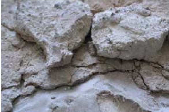
Figura 7 , distacchi interstrato; Figura 8 , strappi occasionali
