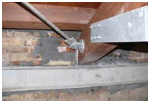
Figura 18 Particolare perimetrale e attacco capriata
