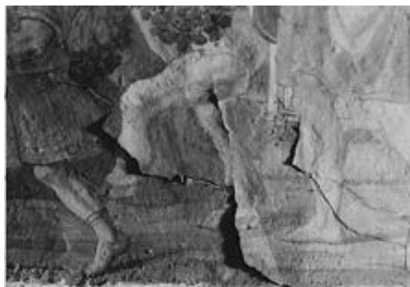
Figura 15. Sala napoleonica: sollevamenti dello strato gessoso
