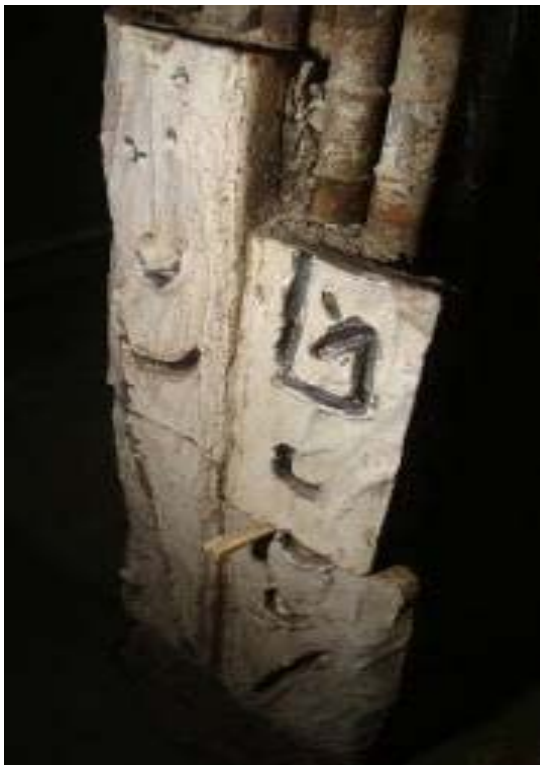
Figure 12. Durante le operazioni di smontaggio delle formelle.
