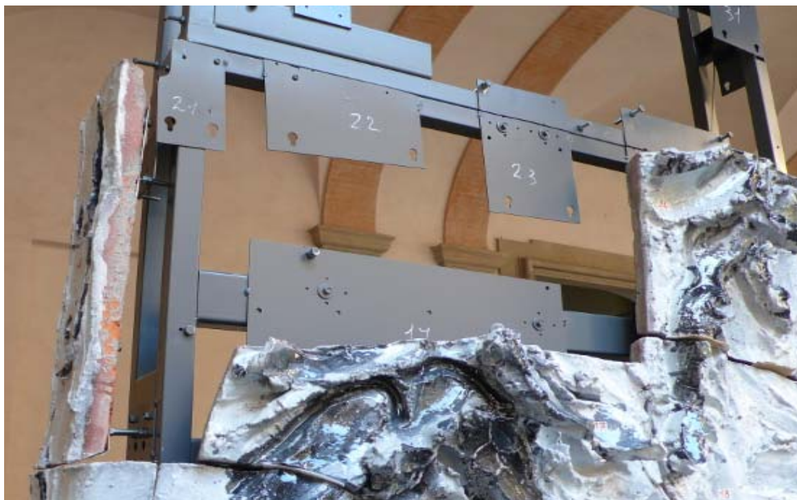
Figure 22. Particolare durante le operazioni di montaggio.
