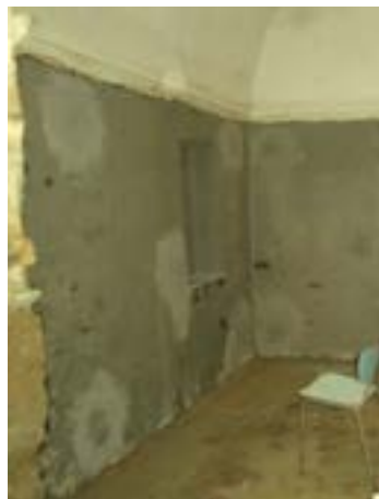
Figura 10 Intervento di fasciatura con fibre di carbonio
