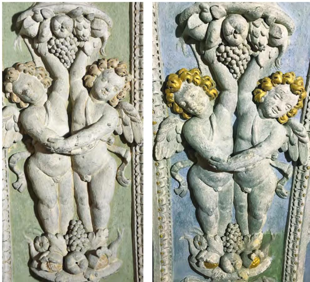
**Fig. 5** - Torricella, chiesa dei Santi Biagio e Maurizio, presbiterio, stucchi prima della pulitura. È ancora visibile il tinteggio soprapposto nell'ultimo intervento, gli stucchi appaiono occlusi nei modellati.
