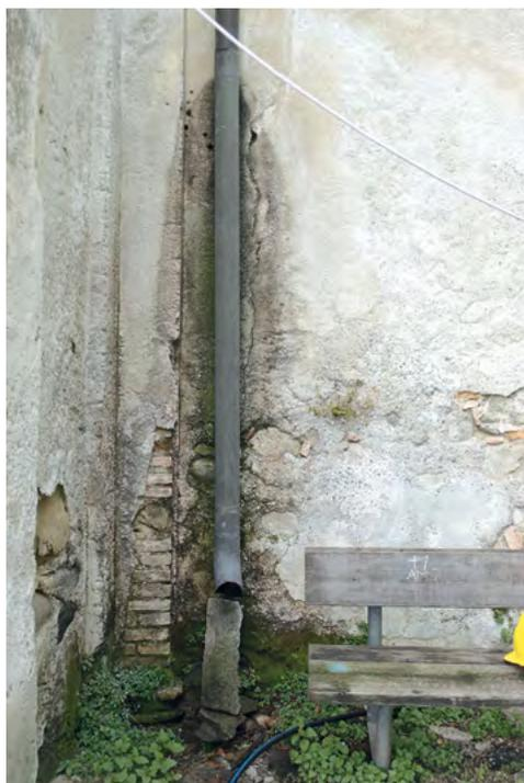
**Fig. 27** - Parete esterna sud-est. Canale di raccolta delle acque piovane troppo corto e a ridosso della muratura.
