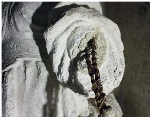
**Fig. 7** - Volta. Capitelli. Particolare di frammento di coppo usato come sostegno delle foglie di acanto.
