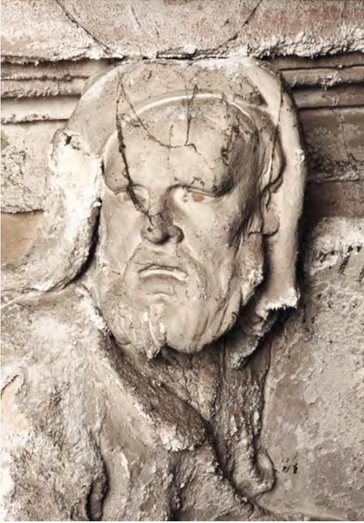
**Fig. 10** - Le efflorescenze saline sono la principale causa di degrado dell'apparato decorativo a stucco. (©Orazio Truglio, Variego, Milano 2012).
