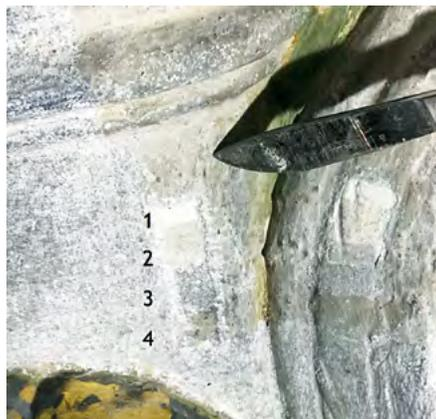
**Fig. 1** - Torricella, chiesa dei Santi Biagio e Maurizio, presbiterio: prova di pulitura con asportazione meccanica dell'ultimo tinteggio.
