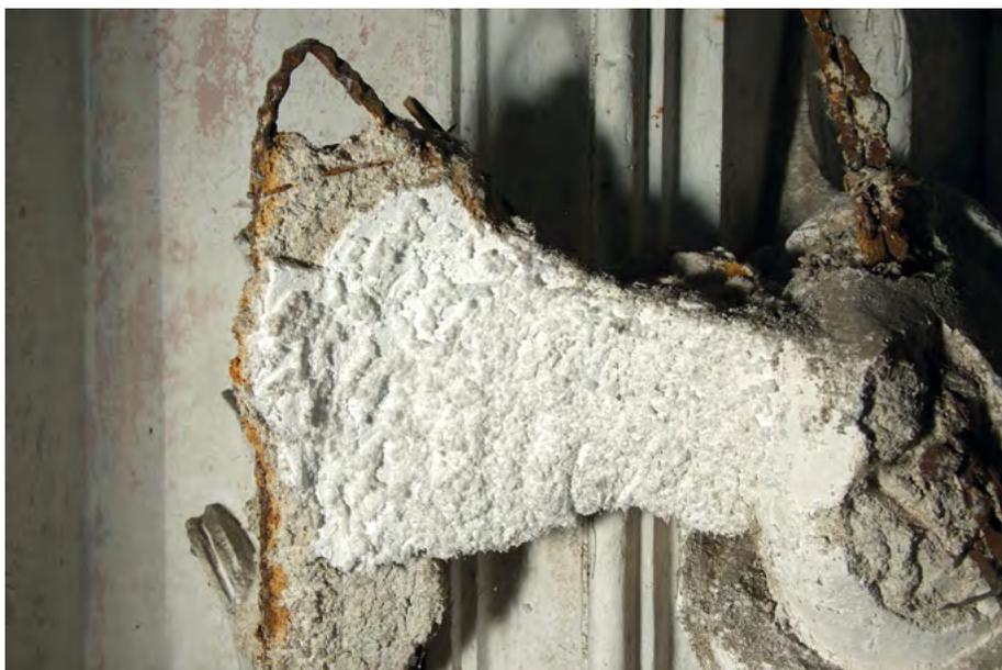
**Fig. 24** - Parete ovest. San Giuseppe. Ala dell'angelo in cui si vedono le spesse efflorescenze saline che ricoprono gran parte della superficie.
