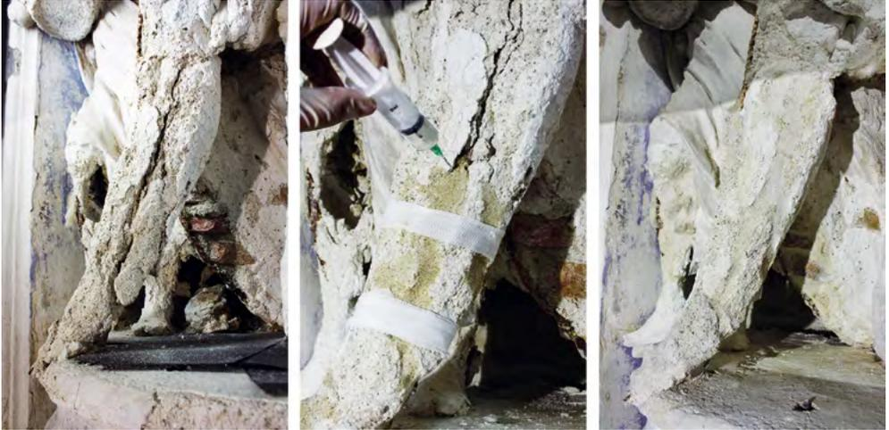
**Fig. 30** - Fasi di consolidamento della gamba di San Carlo – prima dell'intervento, durante l'iniezione della malta fluida nella frattura, con le bende elastiche per la tenuta della forma, e dopo il consolidamento e la microstuccatura delle fessure.
