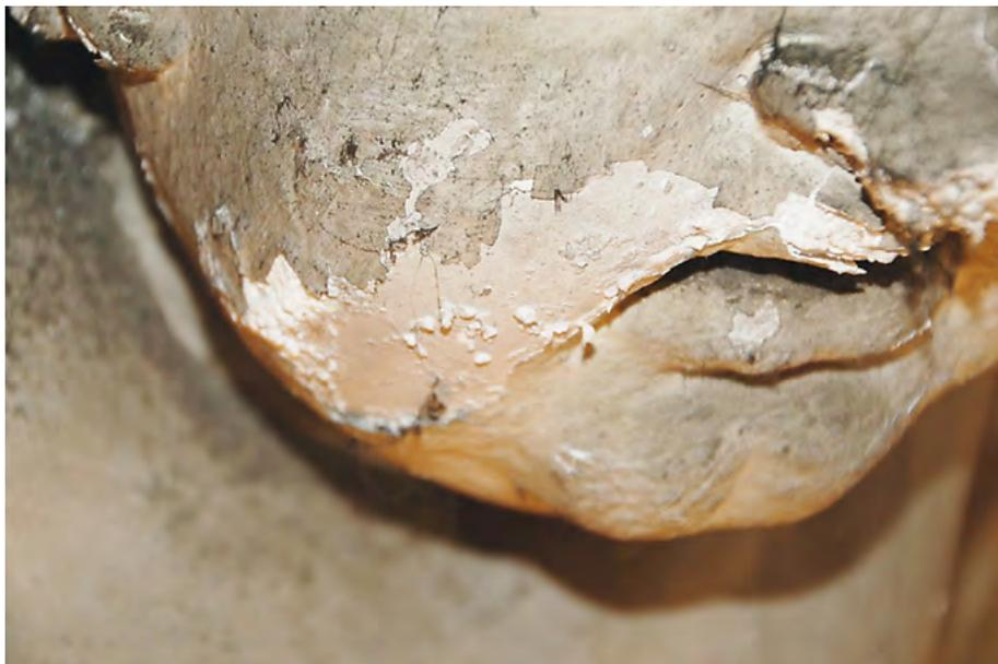
**Fig. 11** - Le efflorescenze saline sono la principale causa di degrado dell'apparato decorativo a stucco. (© Albani, 2012).
