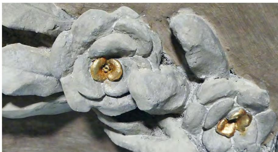
**Fig. 4** - Ristabilimento difetti di adesione e coesione, stuccature e integrazione pittorica con prodotti a base di nanocalci.
