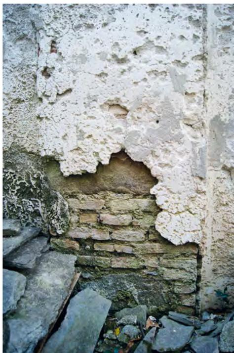
**Fig. 28** - Parete esterna nord-ovest. Presenza di distacchi dell'intonaco.
