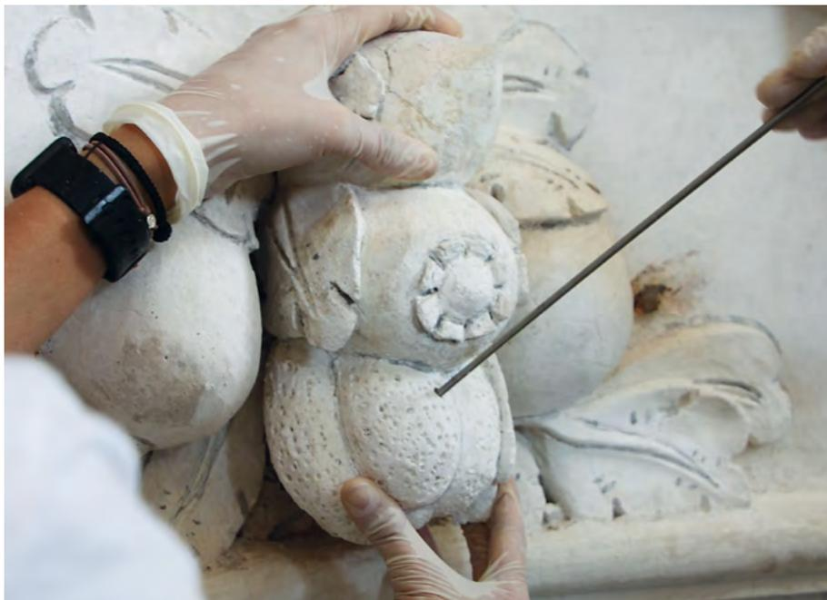
**Fig. 36** - Particolare durante l'innesto di un perno nei frutti del capitello completamente distaccati dal supporto.
