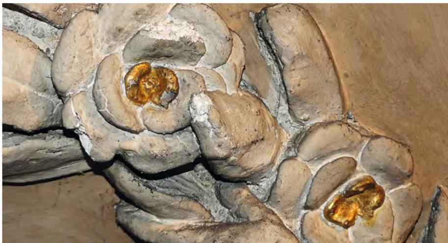
**Fig. 3** - Vela della cappella della Madonna Assunta, dettaglio: difetti di adesione degli stucchi.
