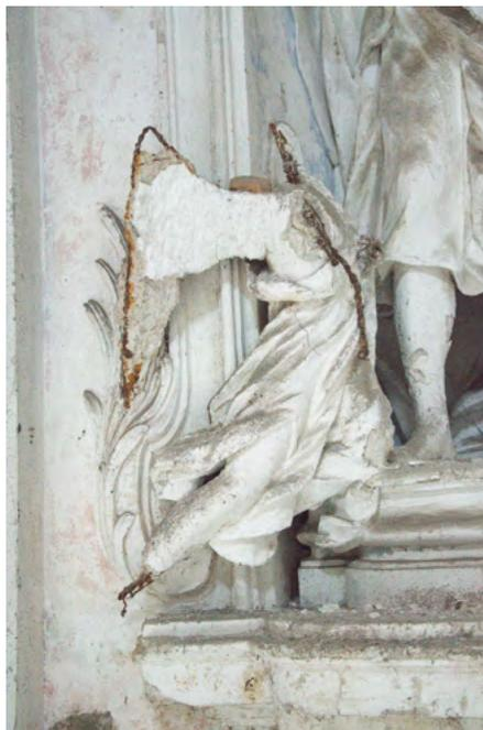
**Fig. 9** - Parete sud. Angeli del fastigio. Sono visibili le vergelle utilizzate come armatura di braccia e gambe.
