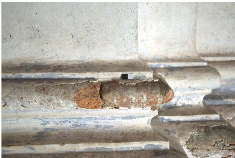
**Fig. 6** - Parete nord-ovest. Dettaglio di un mattone sagomato impiegato per la costruzione del basamento della lesena.
