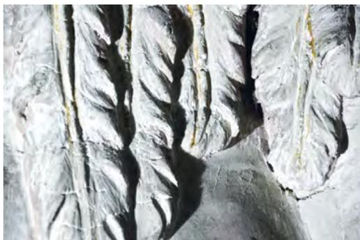
**Fig. 8** - Castel San Pietro, chiesa di Sant'Eusebio, cappella del Crocefisso, putto: tracce di colore, segni, raschiature, microabrasioni sulle superfici descialbate.
