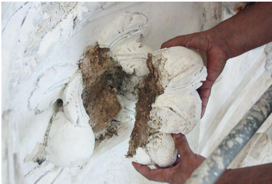
**Fig. 35** - Asportazione dell'elemento con i tre frutti, completamente distaccato e solamente "poggiato" nella sede, privo di ancoraggi o imperniature metalliche.
