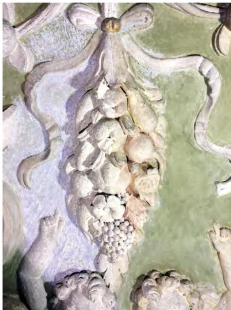
**Fig. 3** - Torricella, chiesa dei Santi Biagio e Maurizio, presbiterio, prova di pulitura: asportazione meccanica dell'ultimo tinteggio con ausilio di metodi meccanici quali vibroincisori, spatole e bisturi.
