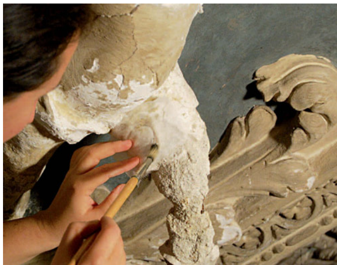
Stabilizzazione dell'intonaco con velinature.
