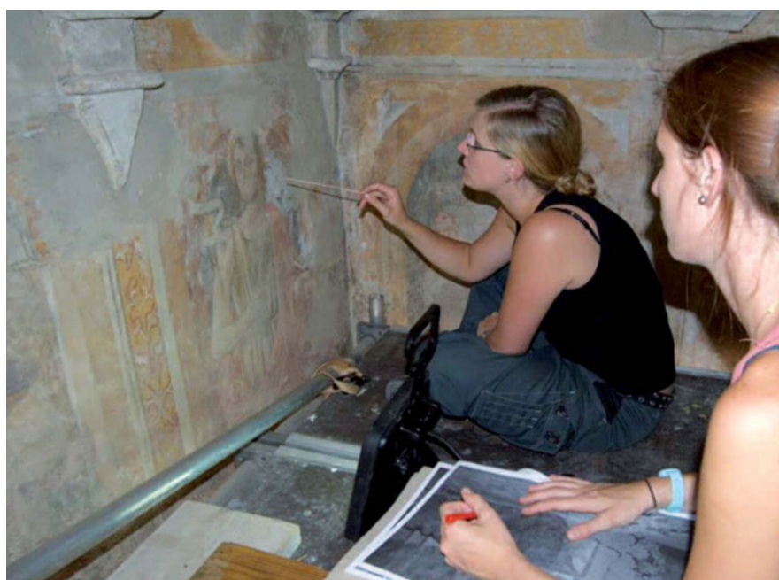
Sopra: Stuccature alla base delle murature.
