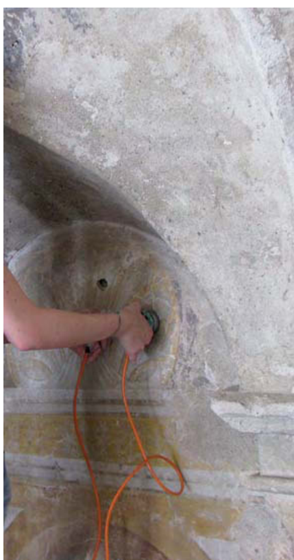
Fig. 4 – Indagini con strumentazione ultrasonica, Chiesa di San Nazario, Dino. Posizionamento delle sonde a contatto della superficie. Collaborazione con Boviar® S.r.l. di Milano.
