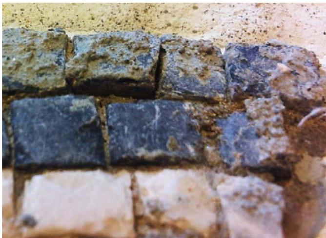
Fig. II.88 - Particolare alcuni residui di malta debordante sul fronte delle tessere.
