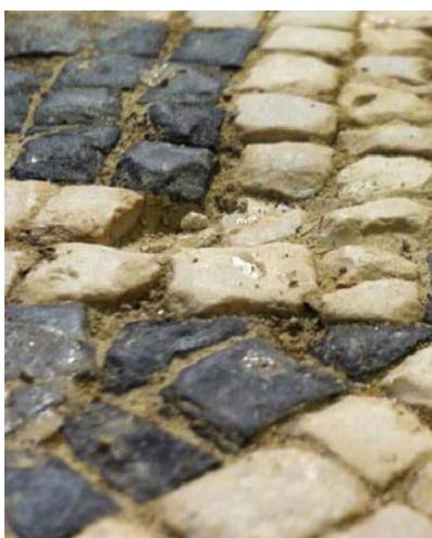
Fig. II.91 - Deformazione del brano musivo causata dalla funzione pavimentale del manufatto e dal lungo periodo d'interramento.
