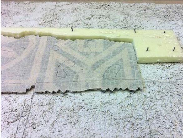
Fig. III.45 - Particolare dei segni di riferimento e della sponda sagomata posizionati per allettare i lacerti.
