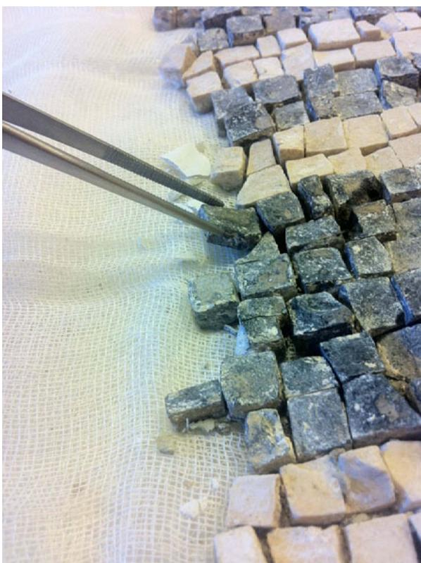
Fig. III.18 - Ricollocamento di una tessera nella posizione originale.
