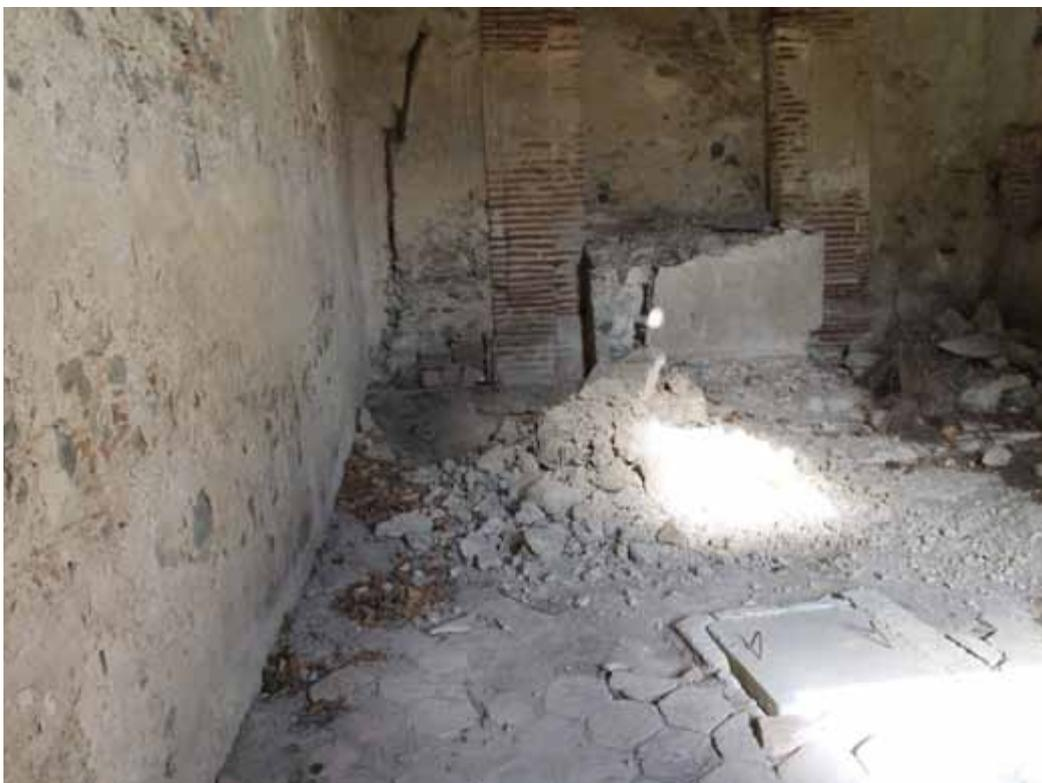
18.7: Villaggio Massa S. Nicola (Me) - Interno della chiesa. Si noti la traccia della posizione della precedente abside sulla muratura di fondo concorde anche con l'orientamento della botola della cripta che mostra un disassamento rispetto allo sviluppo dell'aula indicando una sostanziale trasformazione dell'assetto originario dell'edificio, che in una fase successiva a quella di primo impianto è stato ricodtruito quasi totalmente ruotandolo di alcuni gradi rispetto al suo asse originario.
