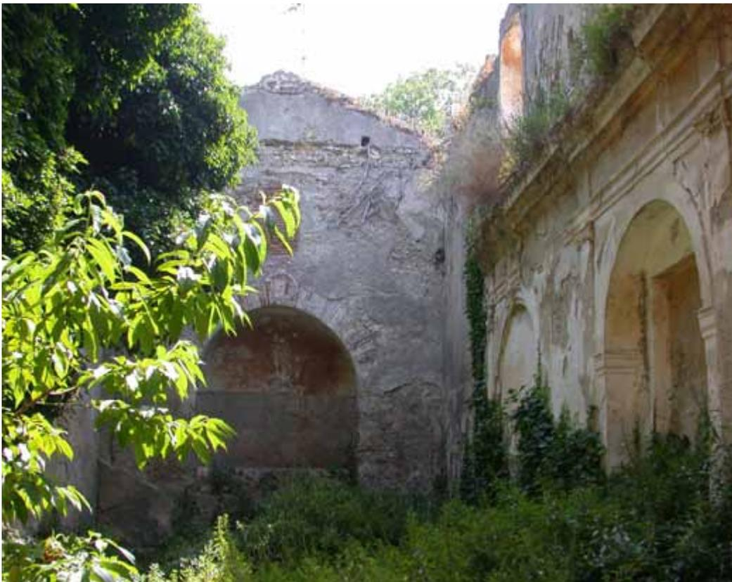
2.4: Interno del rudere della chiesa di S. Filippo il Grande. Sono ancora visibili gli apparati in stucco presenti lungo le murature longitudinali.
