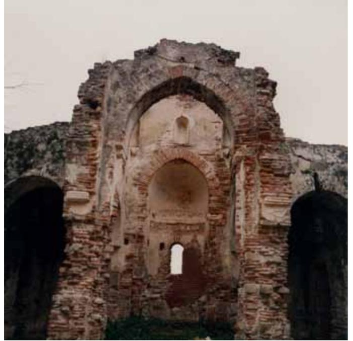
Il differente colore riscontrabile anche tra mattoni di uguale dimensione, che appare verificato in più esempi, andrebbe spiegato per la differente posizione nella cottura, probabilmente svoltasi in prossimità dei diversi cantieri, in fornaci approntate per l'occasione: in generale si può osservare che gli impasti di argilla possiedono, nella maggioranza dei casi, grossolane impurità oltre a contenere al proprio interno sabbia silicea.
