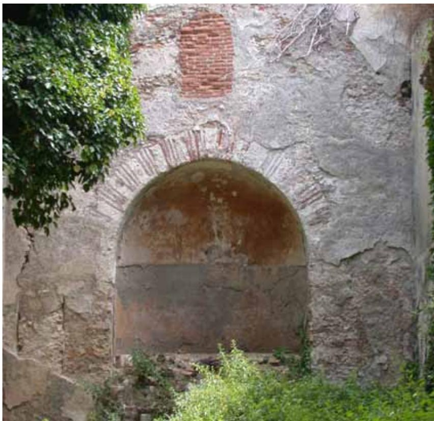
*2.6: Particolare del riempimento in muratura della prothesis.*
