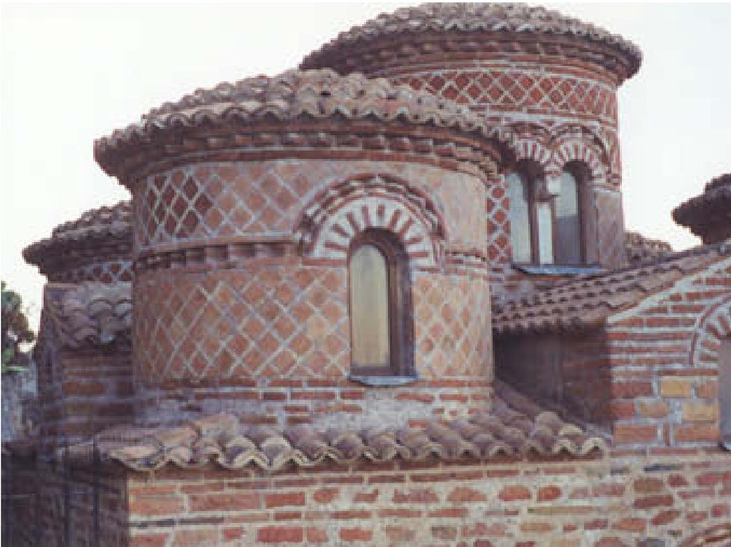
*Fig. 50: Stilo (Rc) La cattolica (IX-X secolo) Particolare delle finestre prive di strombatura.*
