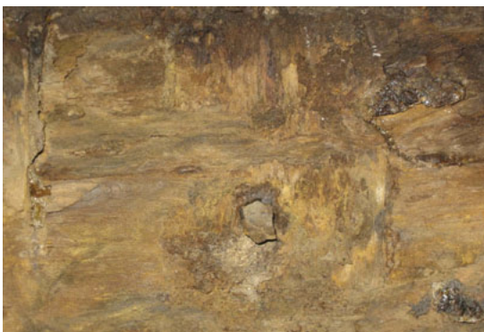
Fig. 12 Particolare del legno antico della cassaforte dopo la pulitura: si riconosce l'attacco fra le tavole orizzontali e il montante destro; si nota la presenza di un perno ligneo.
