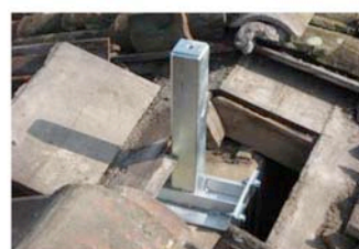
3. Posizionamento e fissaggio dei paletti di ancoraggio strutturale alla trave di colmo
