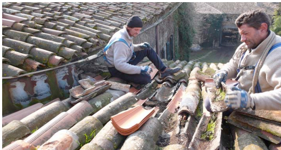
Fig. 9 – Castello di Lurano, coperture Ala Nord: esempio di ricorsa delle coperture, eseguita in sicurezza da personale specializzato
