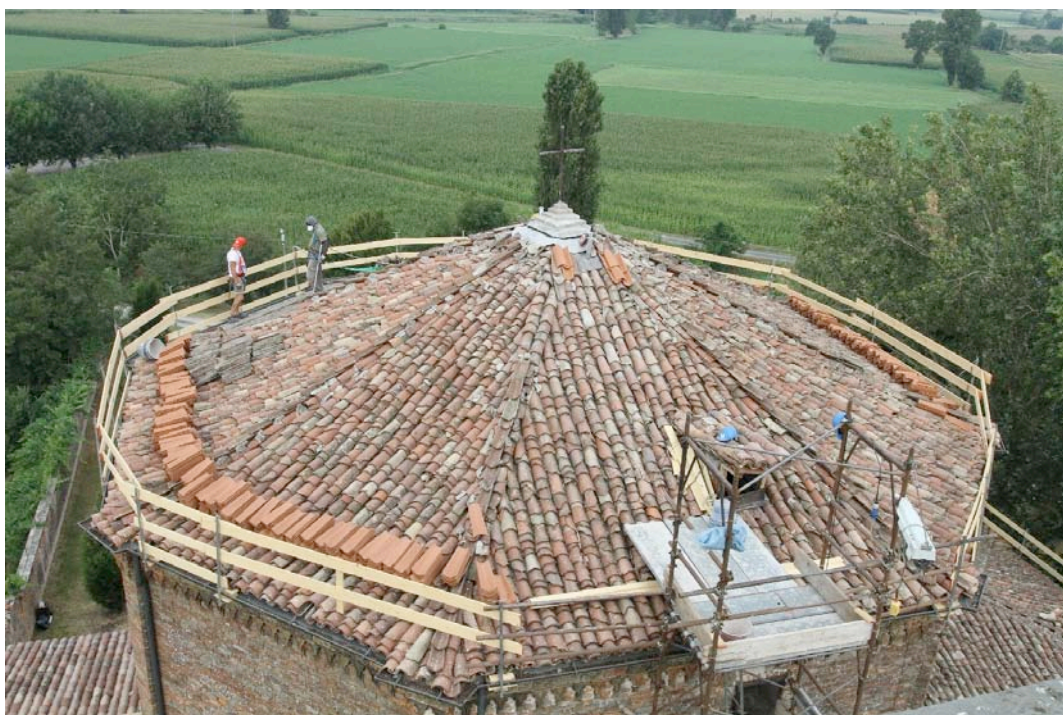
Fig. 11 – Chiesa di S. Maria in Bressanoro: lavori sulle coperture del tiburio
