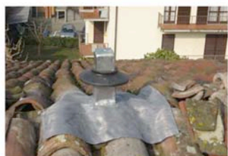
7. Realizzazione sigillatura con scossalina in piombo
