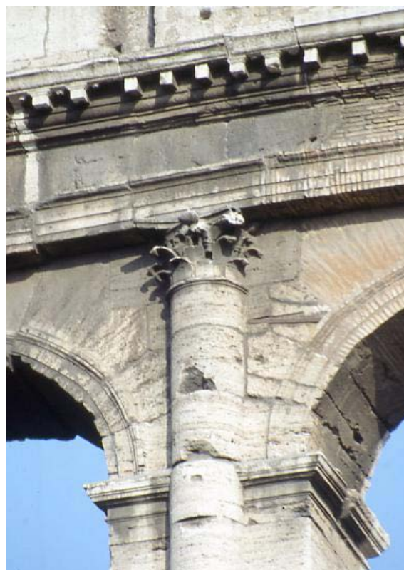
Roma: Colosseo, Particolari dello Sperone di Valadier (1828-29). Notare l'imitazione dei concetti lapidei pentagonali mediante "pacchetti" di laterizi.
