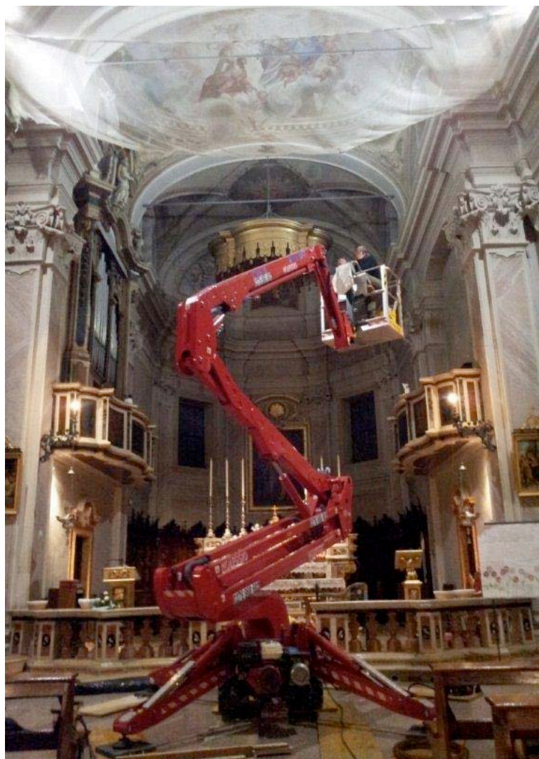
Fig. 4 – Medole, Chiesa dell'Assunzione di Maria Vergine: Navata centrale. Verifiche quadro fessurativo della volta in canniccio.
