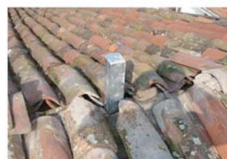
6. Riposizionamento del manto di copertura
