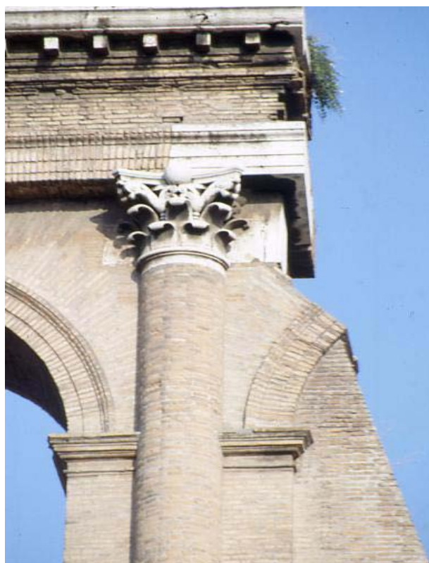
Roma: Colosseo, Particolari dello Sperone di Valadier (1828-29). Notare l'imitazione dei concetti lapidei pentagonali mediante "pacchetti" di laterizi.
