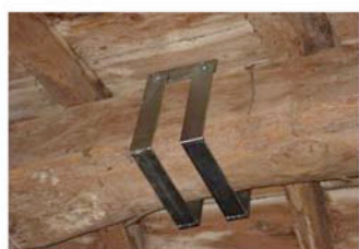
4. Posizionamento e fissaggio dei paletti di ancoraggio strutturale alla trave di colmo
