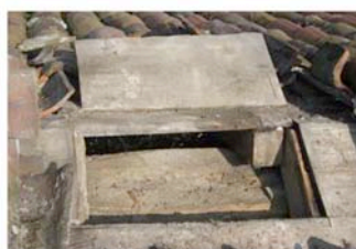
2. Taglio assito in corrispondenza dell'estradosso dei travetti
