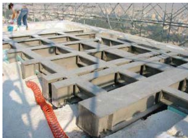
Atene: Il tempio di Athena Nike nel 2004, smontato prima della terza ricostruzione. A lato, il nuovo solaio in acciaio inossidabile.
