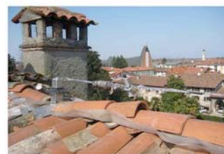
9. Installazione dispositivi di ancoraggio di classe C ai paletti di ancoraggio strutturale
