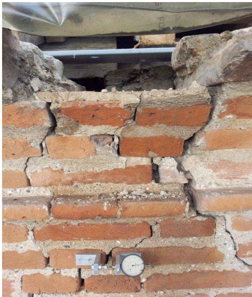
Fig. 1 – Medole, Chiesa dell'Assunzione di Maria Vergine: Cortina muraria lato est. Fessurimetro in corrispondenza dell'appoggio della capriata di copertura.
