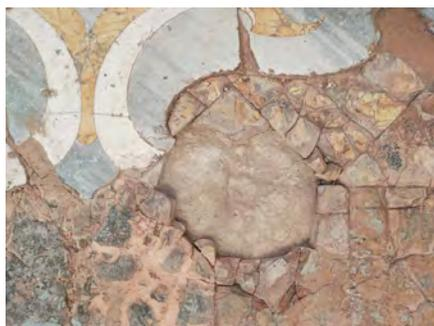
Fig. 18 - Rimozione di una precedente stuccatura.
