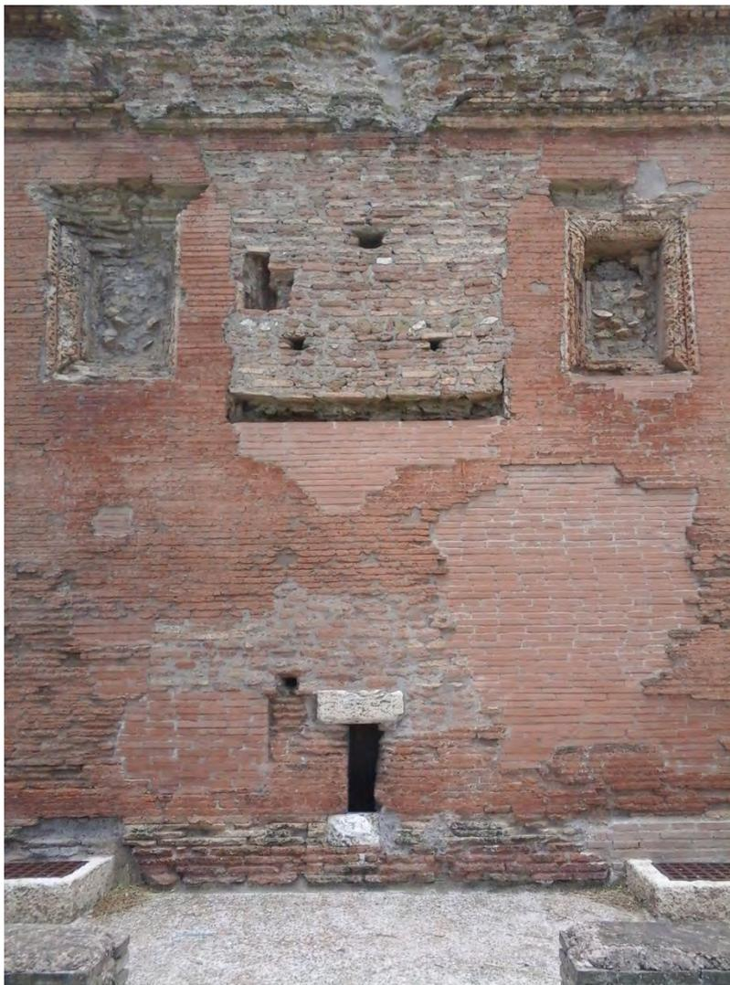
Fig. 4 - Paramento laterizio sul fronte via Latina.
