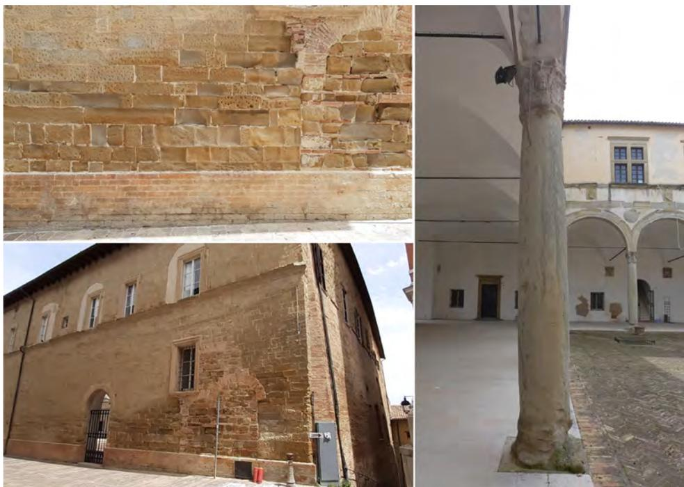
Fig. 4 - Alterazione dell'arenaria di Camerino nella facciata (sx) e nelle colonne (dx) del Palazzo Varano.
