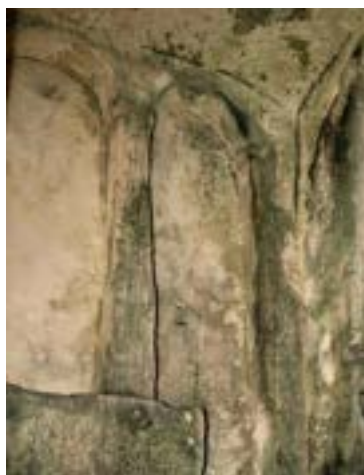
Figura 3 e Figura 4. Tracce della percolazione d'acqua all'interno della chiesa di S. Lucia alle Malve e vista d'insieme dell'interno di S. Barbara (foto di Edoardo Loliva, fotografo ISCR)
