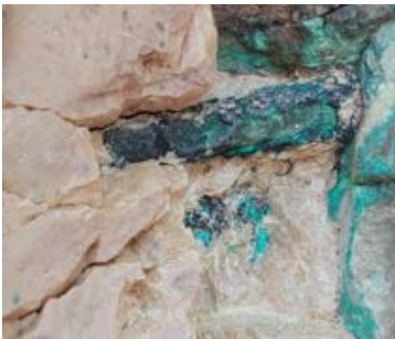
Figura 8. Particolare del perno cilindrico allettato nello zolfo (V. Bruschi, C. Di Marco)
