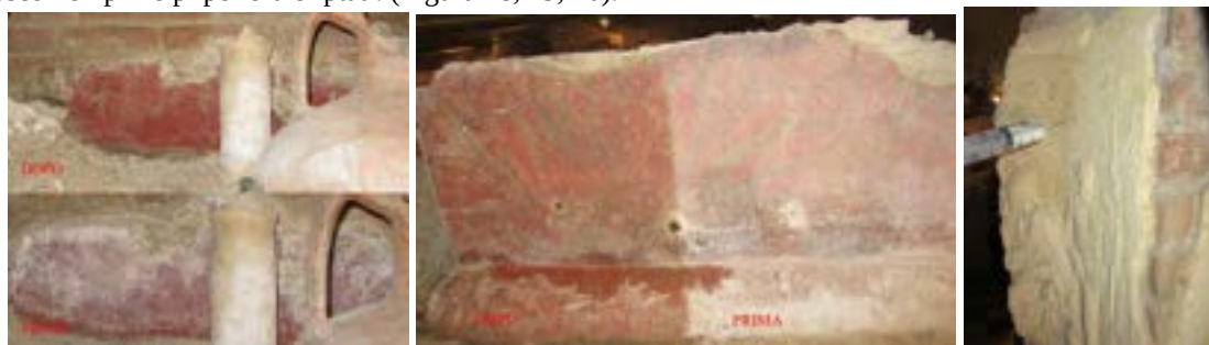
Figura 13-14-15 Intervento di Manutenzione: Rimozione dei Sali e Consolidamento
