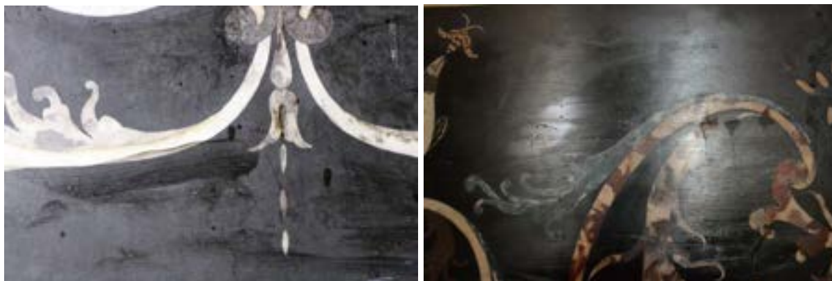
Figure 10 e 11 A sinistra: Palagnedra, Chiesa di San Michele, ridipintura dello strato di fondo per ravvivare la tinta nera, a destra: Comologno, Chiesa di San Giovanni Decollato, segni lasciati sulla superficie della scagliola a seguito della lucidatura periodica effettuata con olio di noce.
