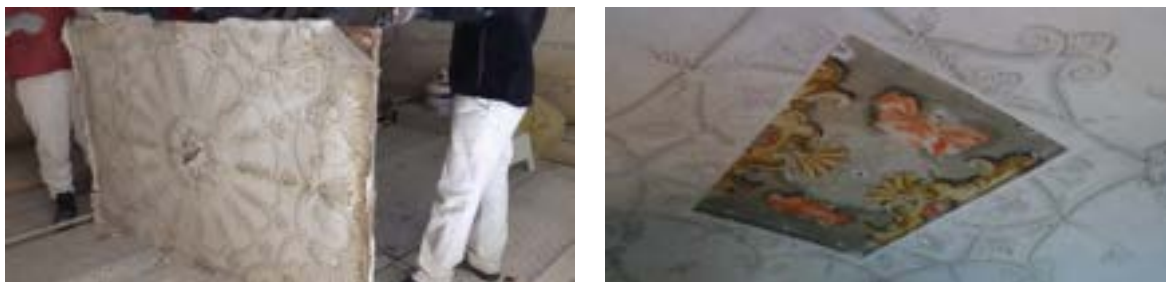
Figura 4-5. Palazzo Malvinni-Malvezzi, vano 35, distacco del telaio con dipinto sottostante di edizione più antica
