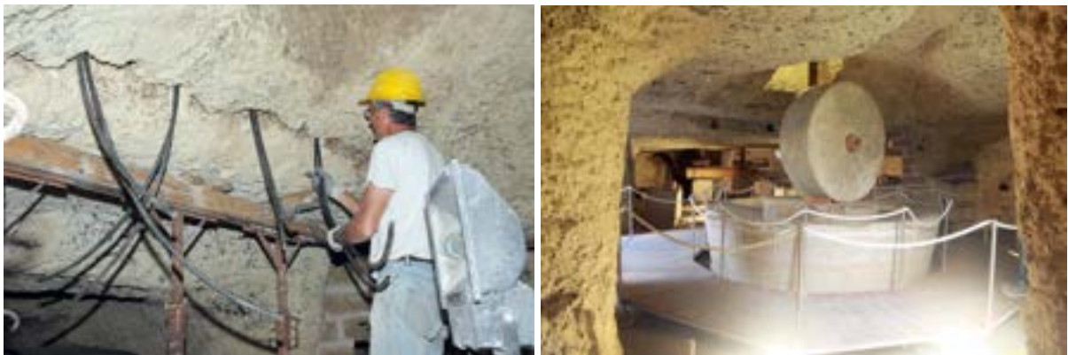
Figura 16. Risarcitura della lesione mediante la realizzazione di fori e l'inserimento di cannule per iniettare la boiaccia (© A. Monte, 2014)
