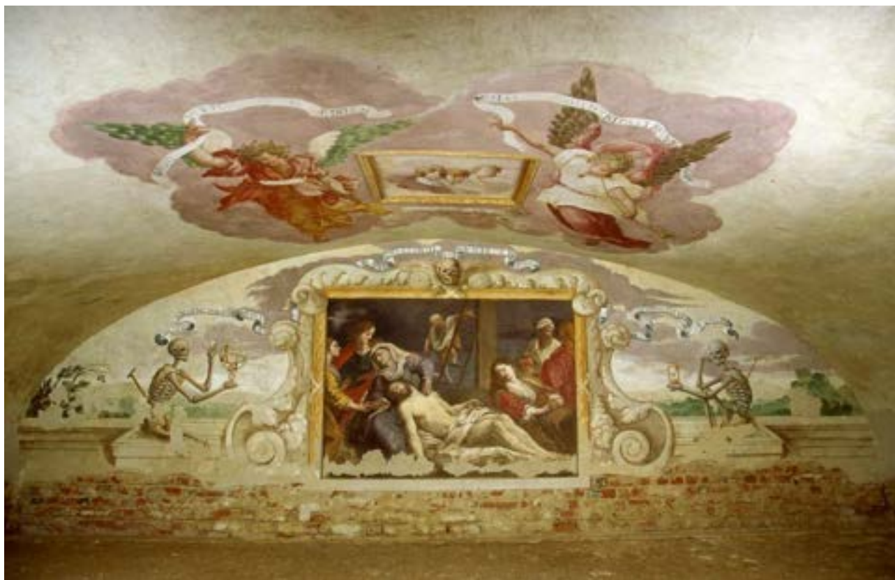
Figura 11. Veduta d'insieme a conclusione dei lavori di restauro del 1999.
