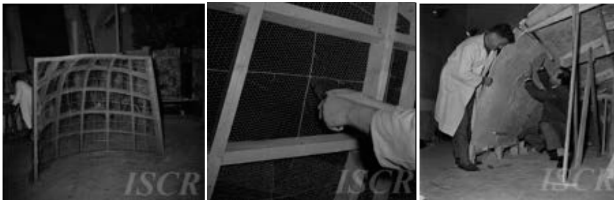
Fig. 3 a,b e c: a) telaio ligneo che costituisce lo scheletro portante del supporto; b) applicazione della rete metallica di rinforzo all'interno del telaio; c) due tecnici dell'Istituto mentre provano il posizionamento dei dipinti sul nuovo supporto
