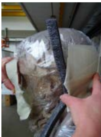
Figura 4 Smontaggio della foderatura
