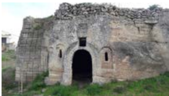
Fig. 1: La facciata del sito di San Vito Vecchio in contrada delle Fornaci. A sinistra si notano i tagli eseguiti durante le operazioni di estrazione della pietra.
