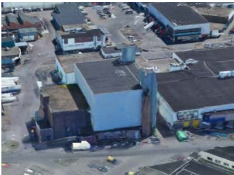
Edificio coperto da lamine metalliche prima della loro rimozione, google earth view
