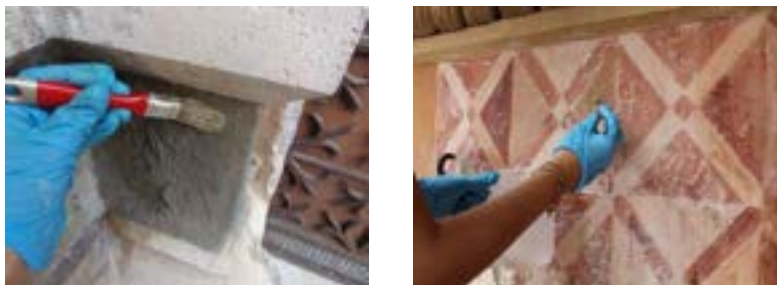
Figure 7-8. Applicazione dei consolidanti in situ : sulle porzioni in pietra serena del basamento, e sul registro inferiore degli intonaci (Foto L. Mangiapelo, M. Bassi)
