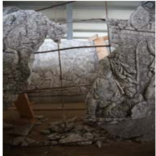
Figura 3. Deformazione e cedimenti della struttura metallica
