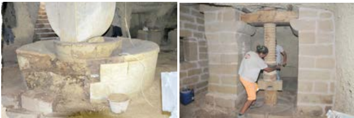
Figura 9. Bacino della vasca della molitura durante la ricostruzione (© A. Monte, 2012) Figura 10. Posizionamento del torchio “alla genovese” nel suo alloggiamento (© A. Monte, 2014)
