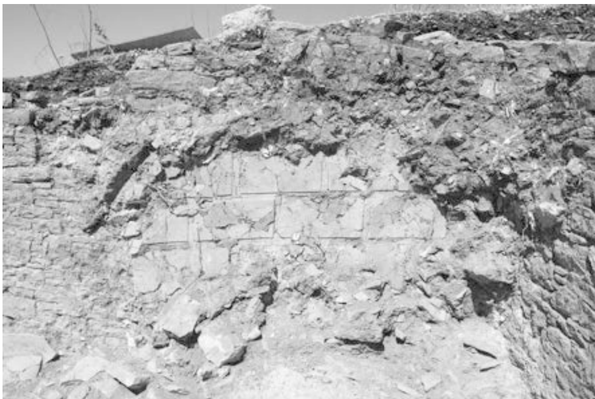
Figura 1. Intonaco solo in parte scoperto e rivestito da terra di scavo.
