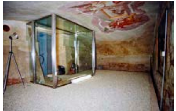
Figura 10. Veduta della bussola-teca dall'interno della cripta. In alto a sinistra uno dei fori di "areazione".
