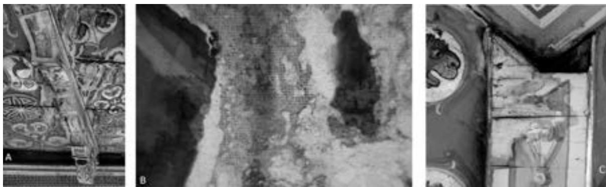
Figure 2. Esempi dei degradi dell'apparato decorativo ligneo. A: mensola con evidenti pregresse deformazioni; B: caduta degli strati pittorici che mostrano l'incamottatura sottostante; C: perdita di strati pittorici applicati direttamente sul legno.
