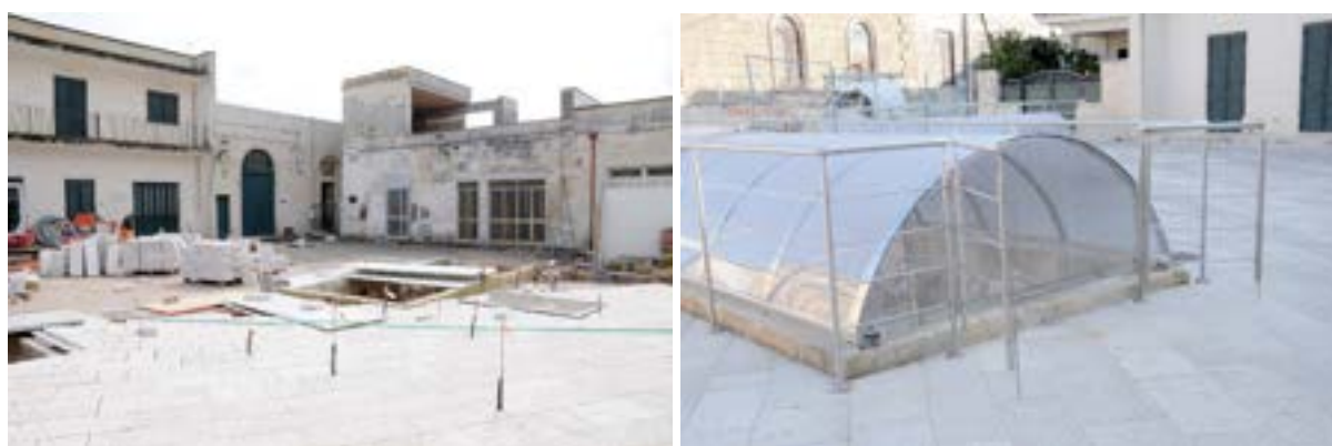
Figura 12. Realizzazione della nuova pavimentazione della soprastante corte (© A. Monte, 2013)
