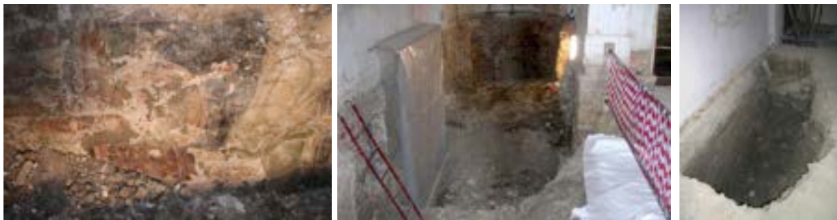
Figure 4, 5, 6. Da sin. particolare del dipinto durante gli scavi, veduta della protezione temporanea e scavo effettuato nel retro del muro
