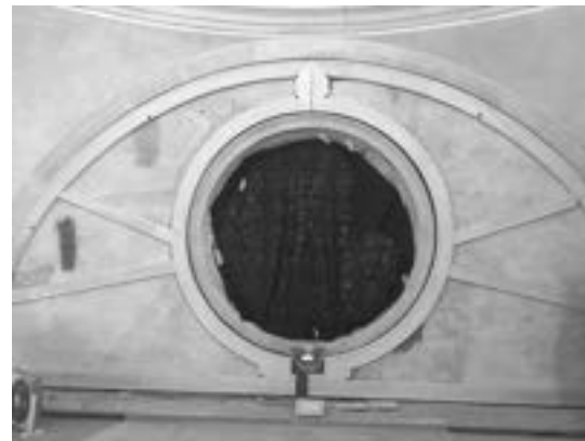
Figura 17. Prove in opera, prima del rimontaggio dei dipinti
