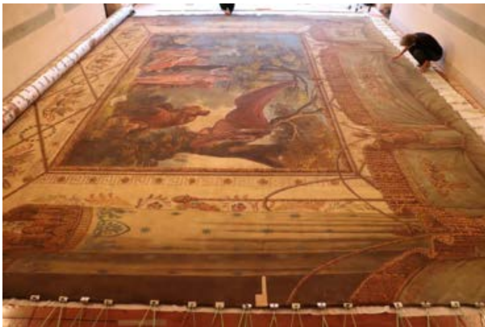
Figura 20. Risultato del tensionamento sui tre lati
