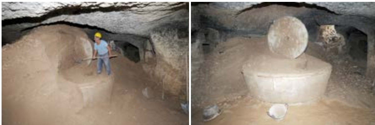
Figura 4. Maglie (LE). Il trappeto durante i lavori di rimozione di terra e altri depositi (© A. Monte, 2012)
