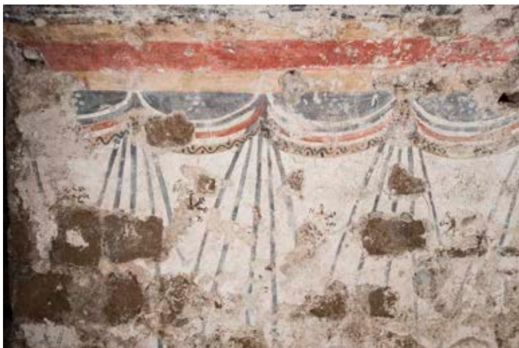
Figure 9-10. La porzione dell'apparato pittorico su cui è stato eseguito il saggio di intervento, prima e dopo.
