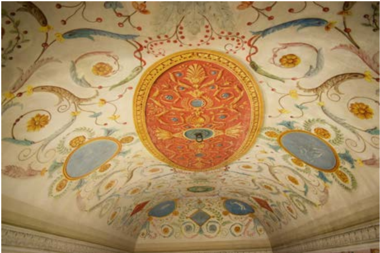
Figura 14-15. Palazzo Malvinni-Malvezzi, vani 39 dopo il restauro
