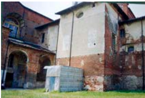
Figura 1. La camera di coibentazione allestita all'esterno dell'entrata alla cripta.
