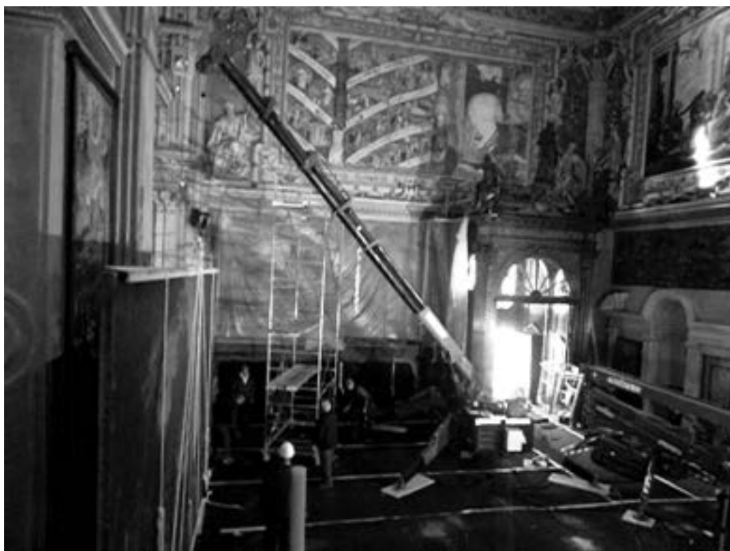
Fig. 5. Dopo la rimozione del telero di Pietro Liberi.
