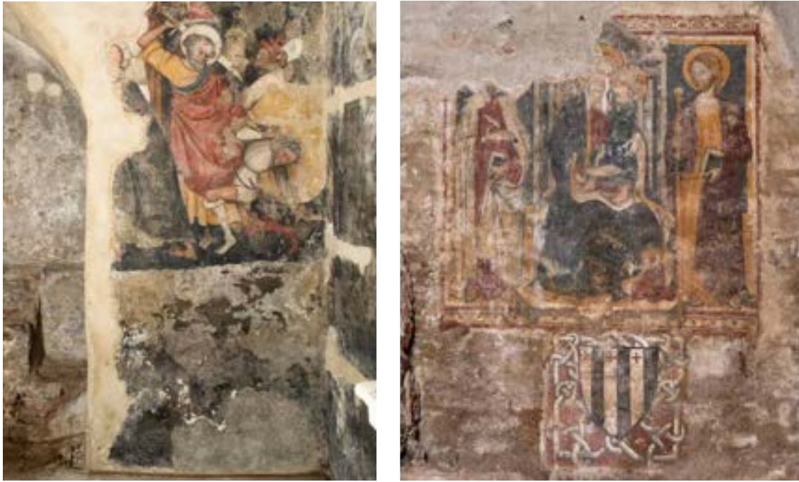
Figure 4 e 5. Saluzzo (CN). Chiesa di San Giovanni. Cappella dei Santi Crispino e Crispiniano: particolare dello stato di conservazione della superficie decorata. Cappella di S. Giuseppe: particolare dello stato di conservazione del dipinto murale.
