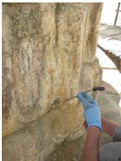
Figure 4, 5 e 6. Dettaglio delle fasi di pulitura iniziale di tipo meccanico, poi con microsabbatrice tipo Garnet, finale di tipo chimico con applicazione di impacchi di carbonato di Ammonio.
