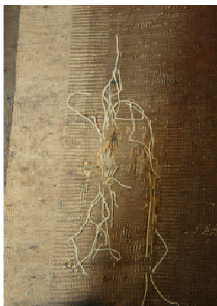
Fig. 15. Particolare prima dell'intervento.
