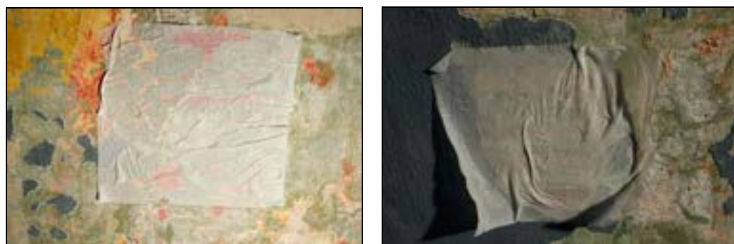
Figure 23 e 24 A sinistra: zona con la rasatura gessosa al di sopra del verde sovrammesso (zona 3). Figura di destra: zona di grafismi neri preconsolidata con soluzione idroalcolica di funori purificata allo 0,5% (zona 4).
