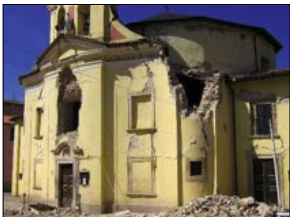
Figure 9 e 10. Esempi di crolli per ribaltamento totale o parziale della facciata (Fonte: immagini web - autore non indicato)
