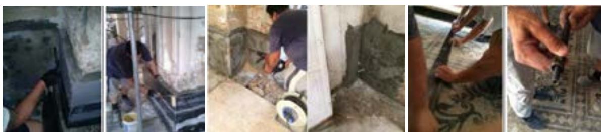
Figure 21, 22 e 23. CERCHIATURA DELLA BASE DEL PILASTRO CON FASCE IN FRP: Realizzazione di fori a rotazione \varnothing 40-50 mm nella struttura propedeutici all'applicazione senza soluzione di continuità delle fasce in FRP; Preparazione delle fasce con soluzione studiata per dare continuità alla cerchiatura mediante arrotolamento intorno a barra pultrusa da inserire entro muratura e sfiohcettura esterna.
