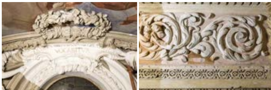
Figura 12,13. Particolari degli stucchi durante il restauro: la scritta nell'arco trionfale e il fondo verde
