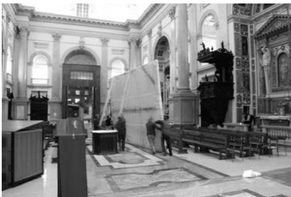
Sotto: Fig. 9. Movimentazione manuale dell'opera con il semplice scorrimento su piccole porzioni di Teflon.
