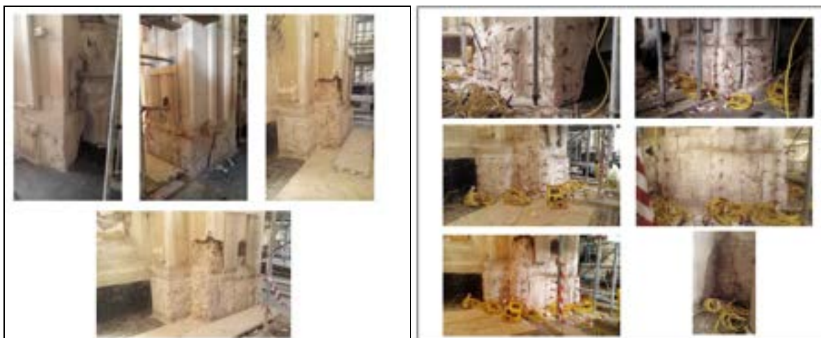
Figure 24, 25 e 26. Tomografia elettrica Porzione inferiore (alla base del pilone) sottoposta ad indagine ante operam . Situazione del pilastro prima e dopo lo stendimento degli elettrodi (G2g Snc).
