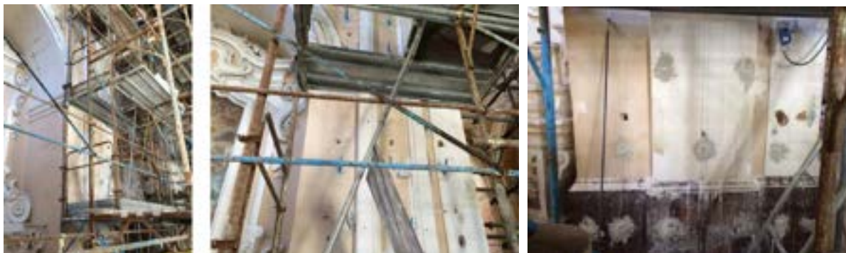
Figure 18, 19 e 20. PRECONSOLIDAMENTO: Esecuzione di perfori a rotazione del diametro \varnothing 30/40 mm per 2/3 della struttura; Sigillatura delle lesioni; Colatura nei fori di malta. CONSOLIDAMENTO: Realizzazione di perfori nelle murature; Iniezione nei fori di boiaccia pozzolanica; Ripresa dei fori per il successivo inserimento delle barre pultruse in FRP e sigillatura fino a saturazione dei fori con resina bi-componente.
