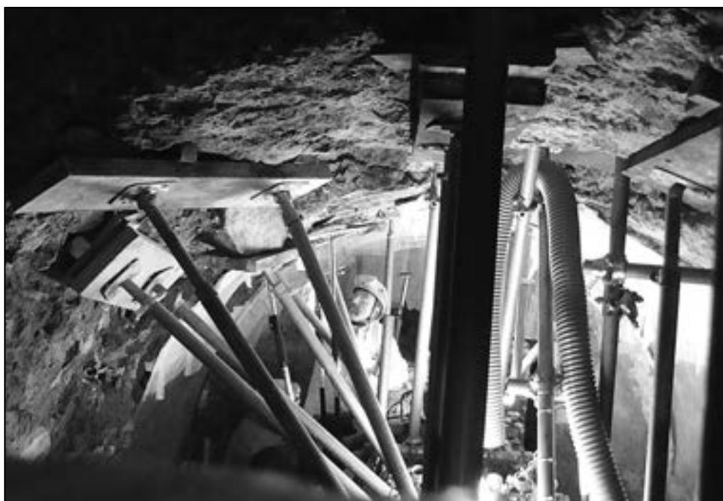
La volta puntellata durante le operazioni di recupero
