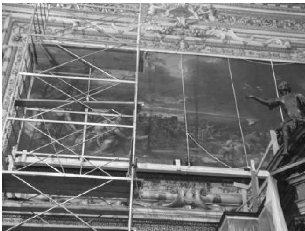
Fig. 3. Avanzamento dell'opera di circa 60 cm sulle barre filettate, con il trave lamellare di appoggio
