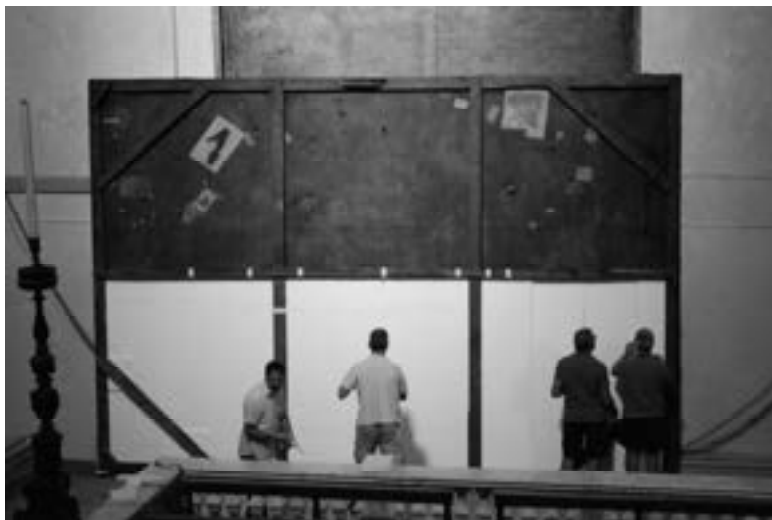
Fig. 6. Inserimento dei pannelli in poliuretano per colmare il vuoto dello spessore del telaio.
