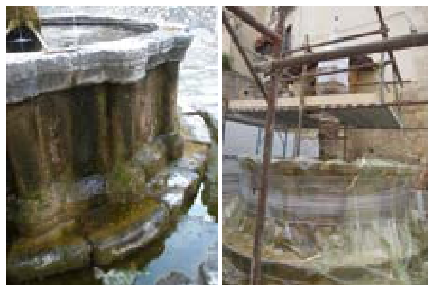
Figure 2 e 3. Dettaglio del basamento della fontana prima dei lavori con le superfici infestate da agenti biologici. A destra vista della fontana durante il trattamento chimico con biocida ad ampio spettro.
