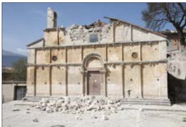
Figure 9 e 10. Esempi di crolli per ribaltamento totale o parziale della facciata (Fonte: immagini web - autore non indicato)
