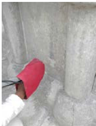
Figure 4, 5 e 6. Dettaglio delle fasi di pulitura iniziale di tipo meccanico, poi con microsabbatrice tipo Garnet, finale di tipo chimico con applicazione di impacchi di carbonato di Ammonio.
