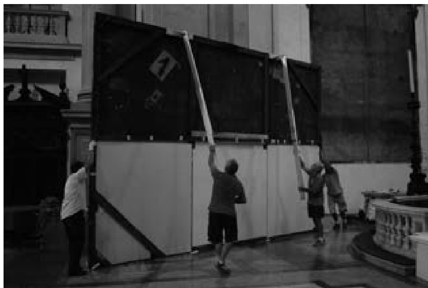
Fig. 7. La prima movimentazione anche attraverso le traverse mobili basculanti.
