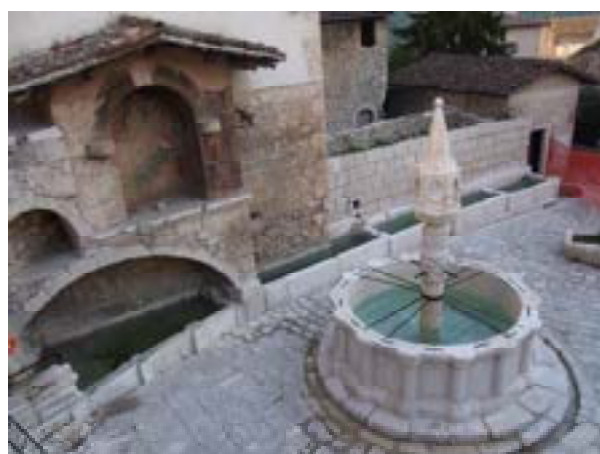
Figura 8. Vista a lavori di restauro conclusi per la fontana e gli abbeveratoi, ancora da eseguire per l'edicola.
