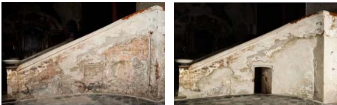
Figure 6 e 7. Saluzzo (CN). Chiesa di San Giovanni. Scalone. Particolare dello stato di conservazione di un lato prima e dopo l'intervento di messa in sicurezza e riordini delle superfici.
