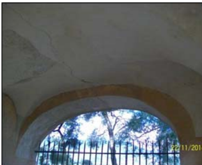
Figure 3 e 4. Lesione del portico e lesione parete della parete Nord con fessurimetro di controllo
