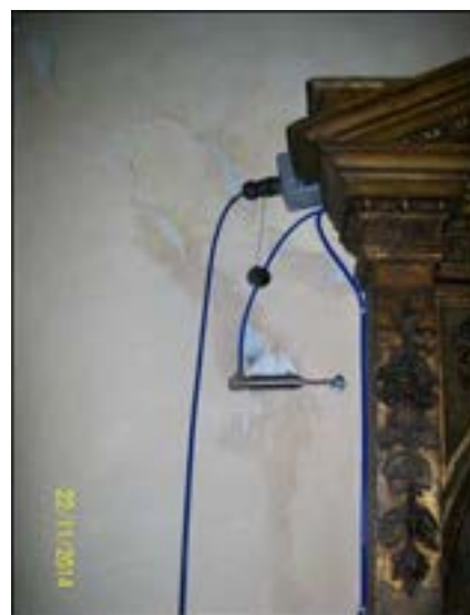
Figure 3 e 4. Lesione del portico e lesione parete della parete Nord con fessurimetro di controllo
